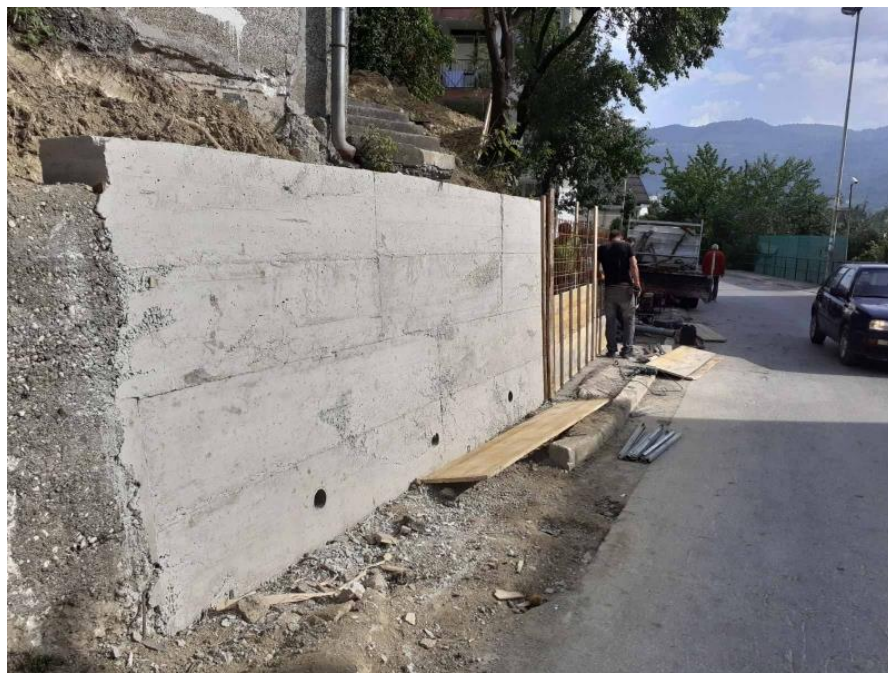
Slika 11. Primjer sanacije betonskog potpornog zida u Gornjim Velešćima, 2020. (foto: Faktor.ba, 2020.)
