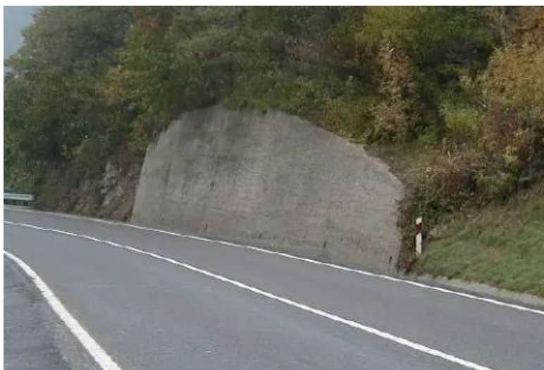
Slika 12. Primjer zida od armiranog betona (foto: Renar d.o.o. i Neuron d.o.o., 2004.)
