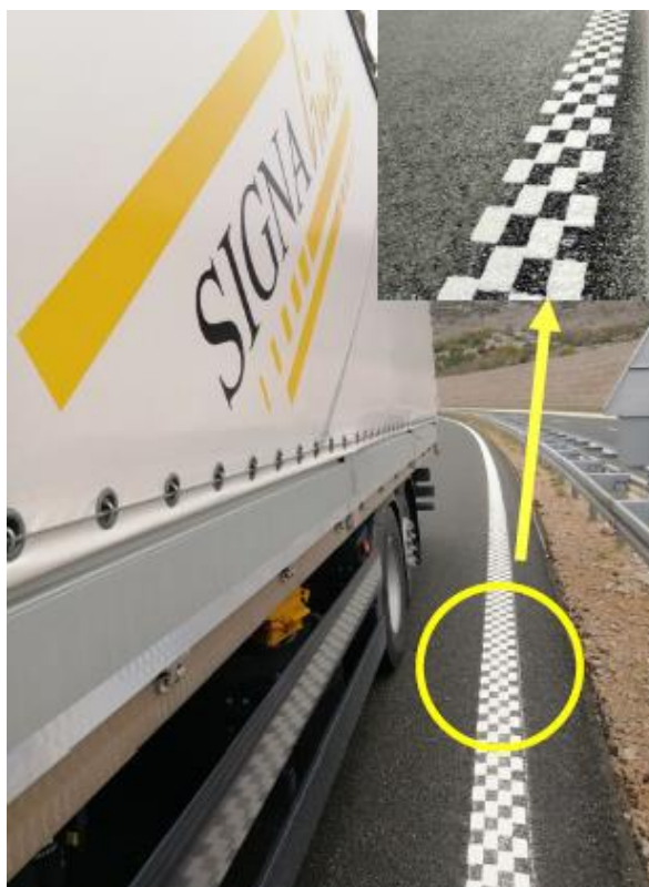
Slika 10. Profilirana horizontalna oznaka [19]
