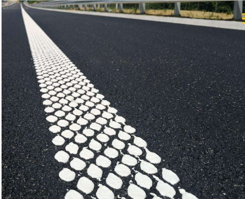
Slika 7. Uzdužna oznaka na autocesti [19]
