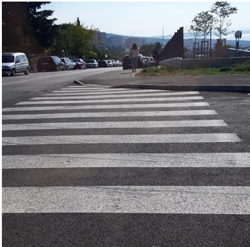
Slika 14. Pješački prijelaz na ulazu u KBC
