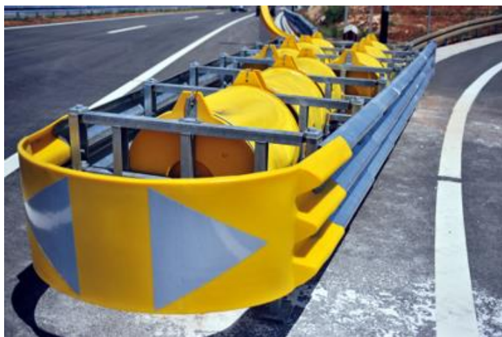
Slika 26. Ublaživač udara [19]
