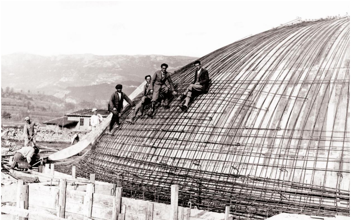
Slika 52: Armatura kupole [6]
