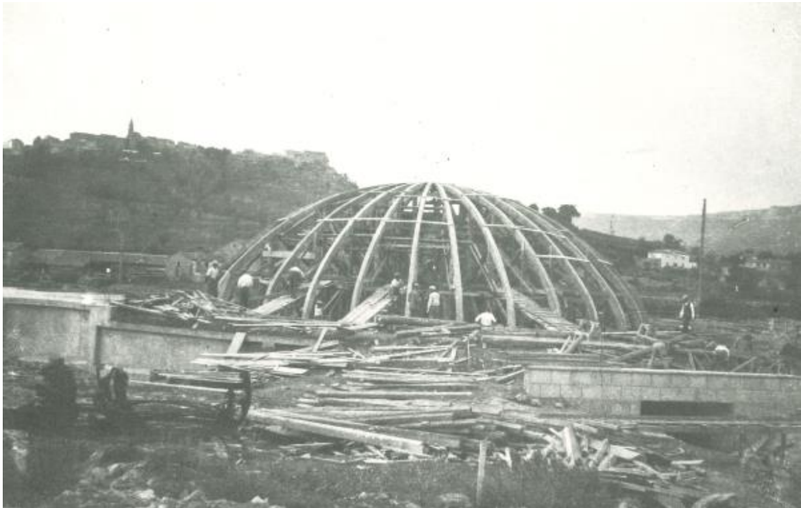
Slika 47: Postavljanje oplata za kupolu [7]
