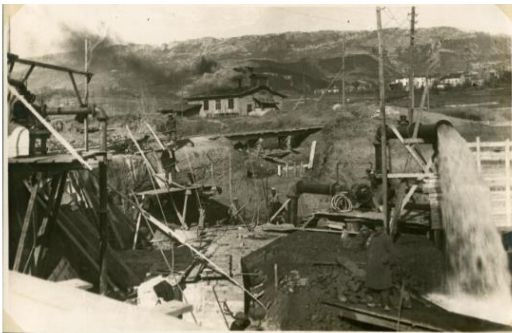
Slika 41: Betoniranje temelja kupole [6]
