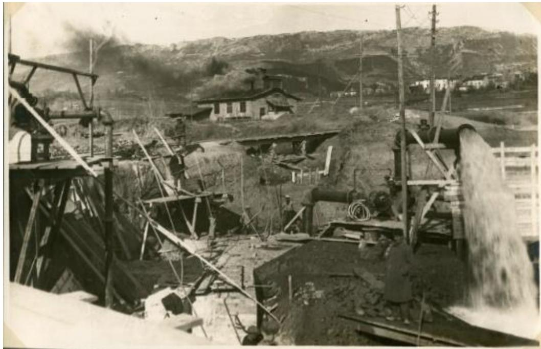
Slika 41: Betoniranje temelja kupole [6]
