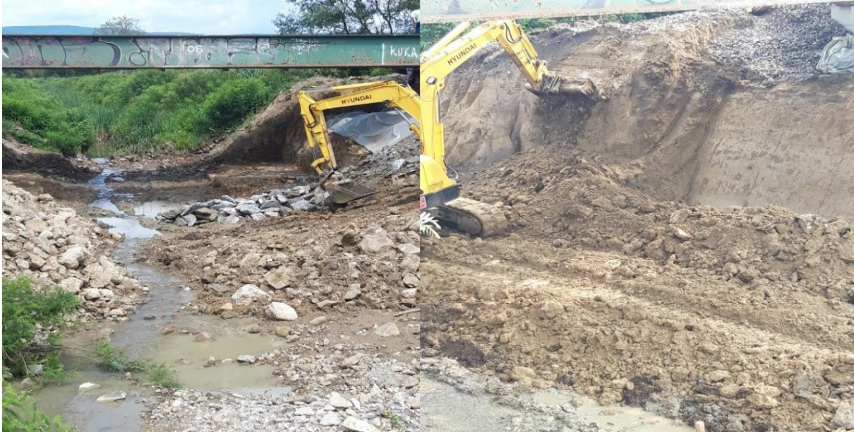
Slika 46. Iskop temelja, Staro Petrovo Selo, Pružne građevine
