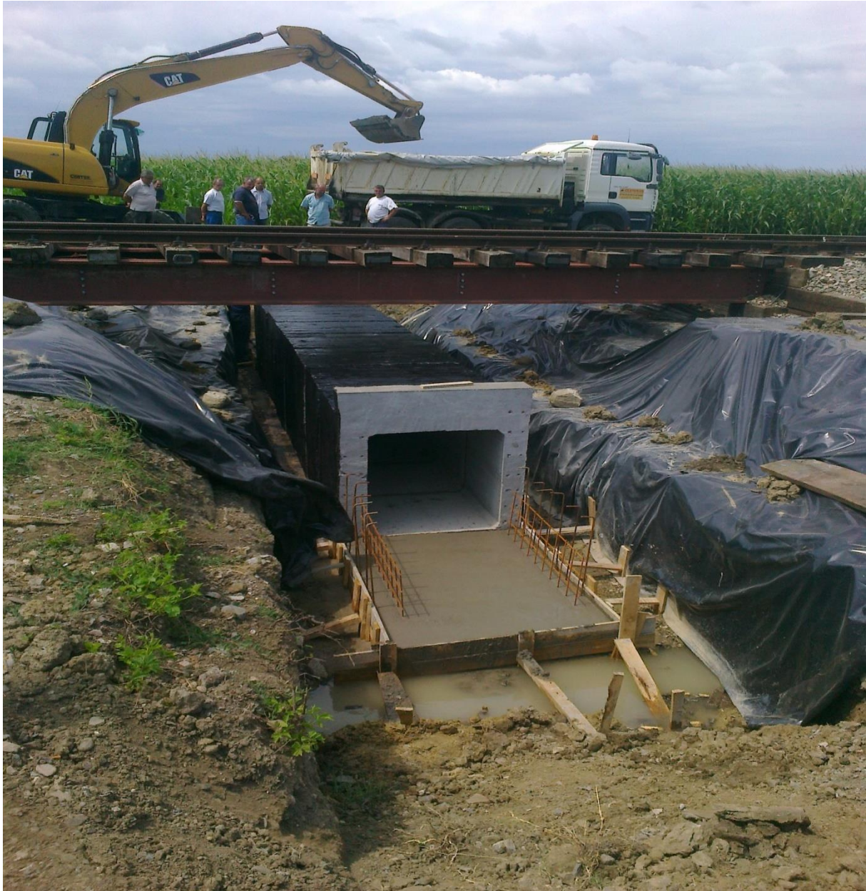
Slika 54. Propust, dionica pruge Vinkovci-Županja, Pružne građevine
