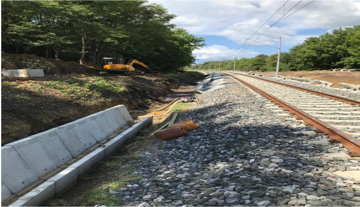
Slika 21. Ugradnja gotovih betonskih odvodnih kanalicica tipa 1, Pružne građevine
