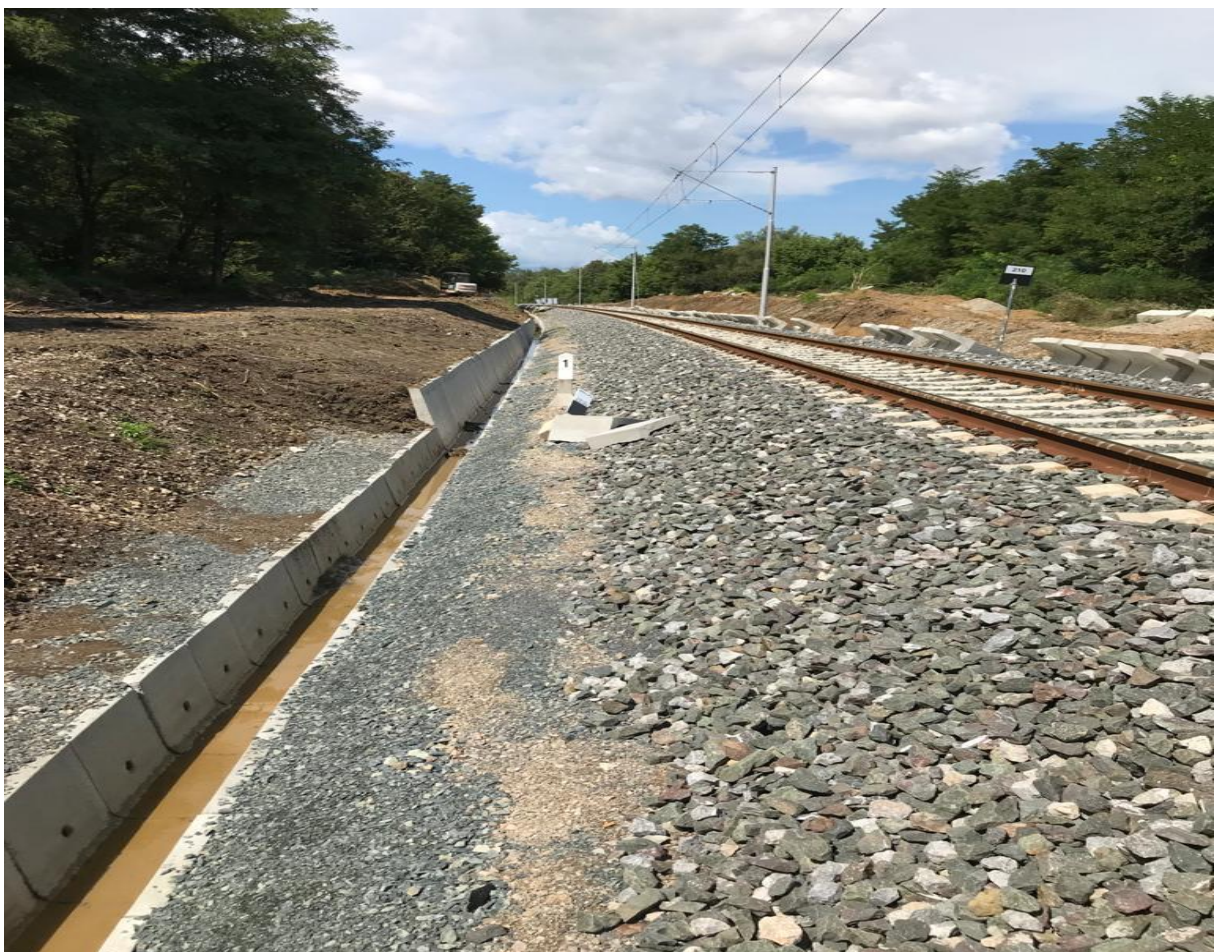
Slika 22. Ugradnja gotovih betonskih odvodnih kanalicica tipa 1 i tipa 2, Pružne građevine
