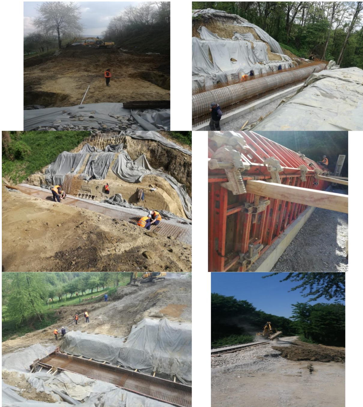
Slika 44. Saniranje klizišta, Đulovac, Pružne građevine
