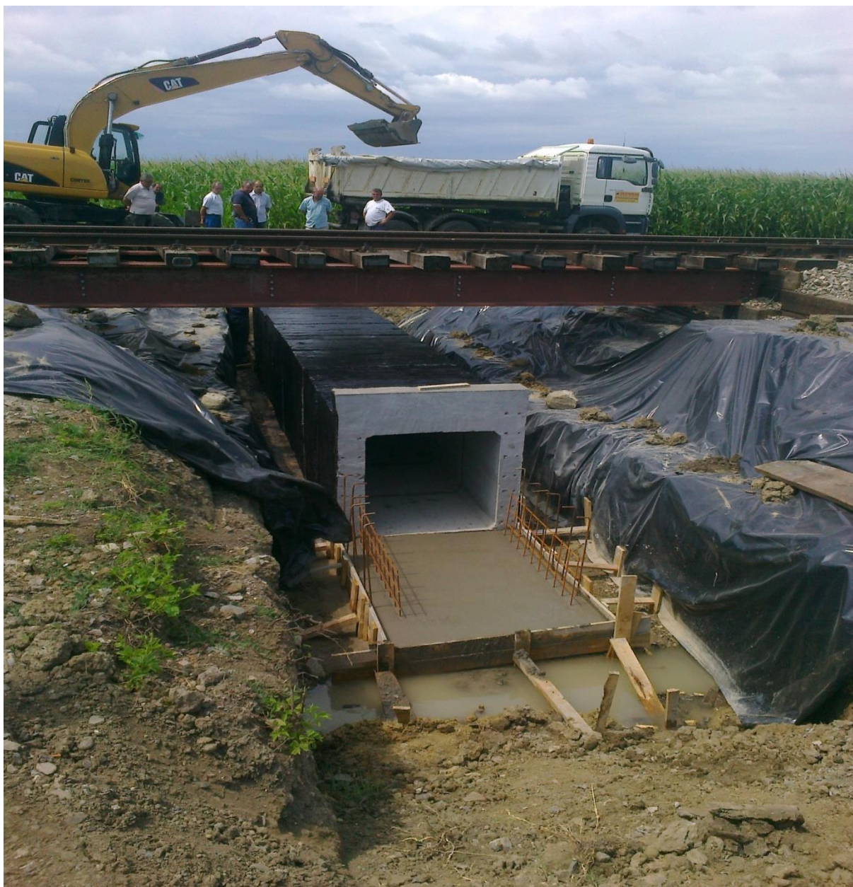
Slika 54. Propust, dionica pruge Vinkovci-Županja, Pružne građevine
