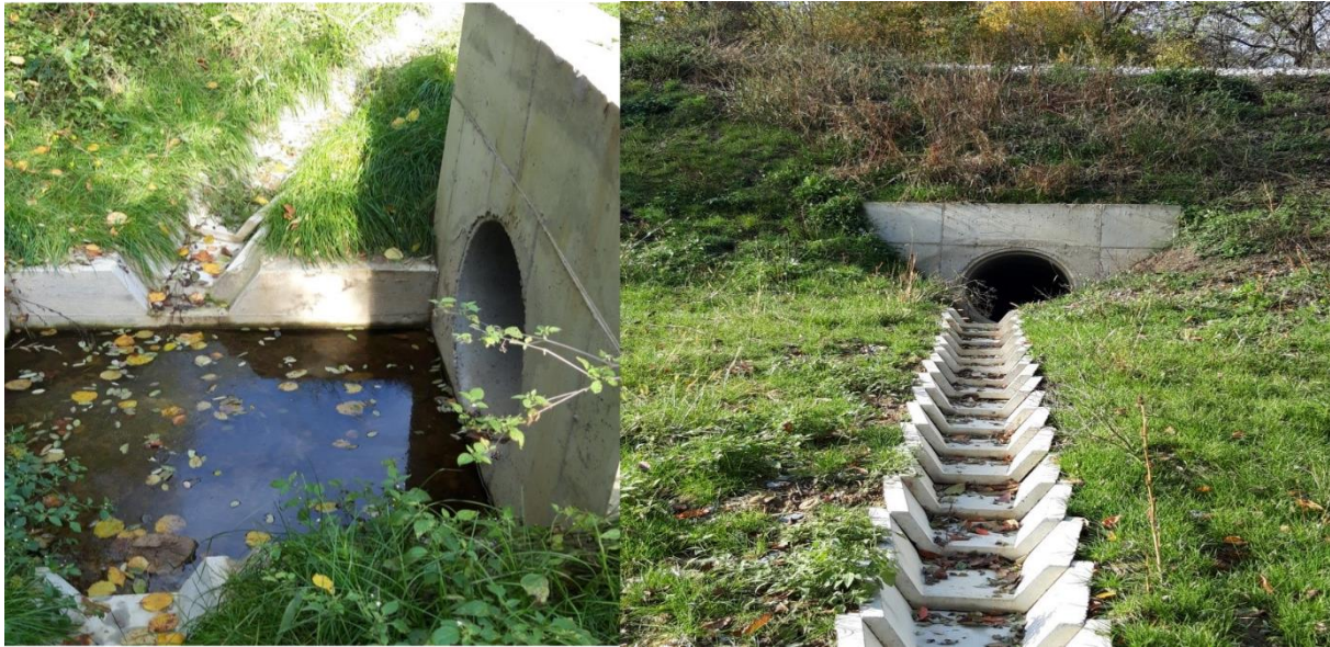
Slika 45. Godinu dana nakon sanacije pruge kod Đulovca, Pružne građevine
