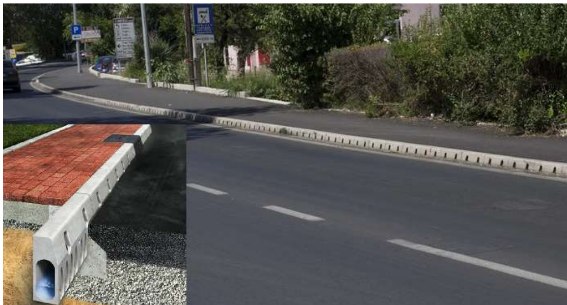
Slika 26: Rubnjak s integriranim linijskim kanalom ( https://www.aco.hr/reference/case-study/dr%C5%BEavna-cesta-d-315-trogir---pantana )
