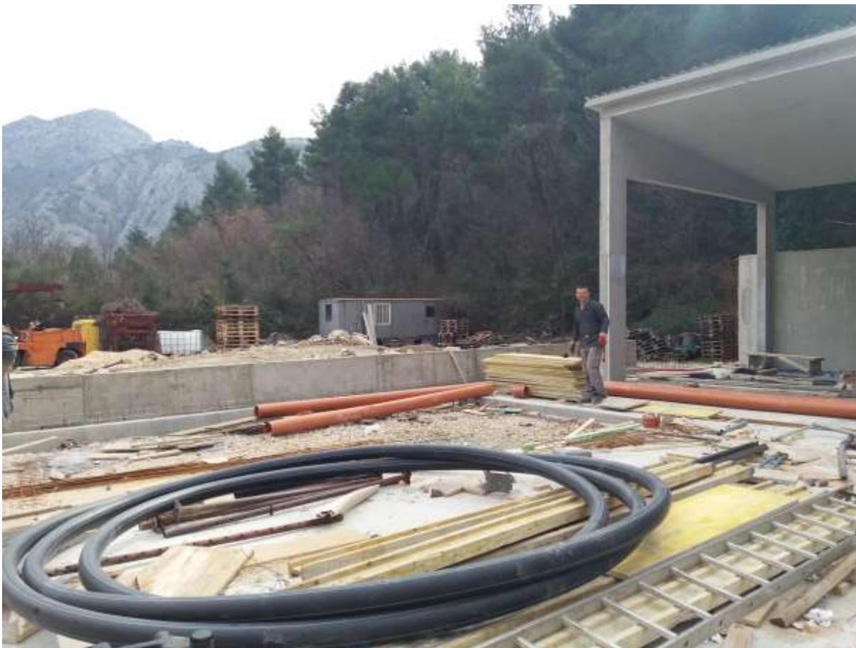
Slika 24. Prikaz vodovodnih i odvodnih cijevu prije polaganja u rovove i sl. ( Izvor: Grad Omiš, Upravni odjel za komunalnu i stambenu djelatnost, prostorno uređenje i zaštitu okoliša, pristup rujun 2022.)
