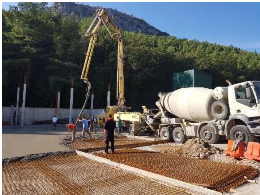
Slika 20. Betoniranje podne ploče manipulativnog prostora( Izvor: Grad Omiš, Upravni odjel za komunalnu i stambenu djelatnost, prostorno uređenje i zaštitu okoliša, pristup rujan 2022.)
