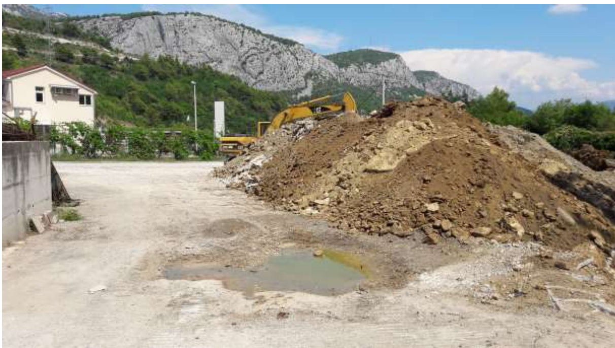
Slika 14. Materijal iz iskopa deponiran na gradilištu ( Izvor: Grad Omiš, Upravni odjel za komunalnu i stambenu djelatnost, prostorno uređenje i zaštitu okoliša, pristup rujana 2022.)
