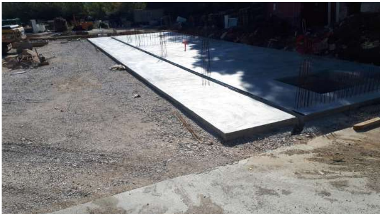
Slika 17. Podna ploča prostora nadstrešnice s otvorom jame sortirnice ( Izvor: Grad Omiš, Upravni odjel za komunalnu i stambenu djelatnost, prostorno uređenje i zaštitu okoliša, pristup rujan 2022.)
