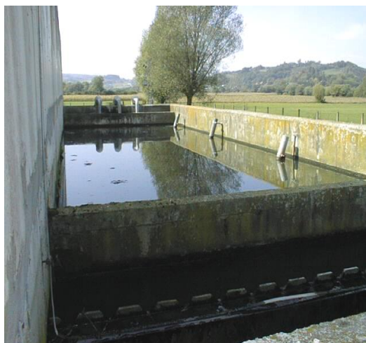
Slika 3: Primarni taložniki i bioeracijski bazen
