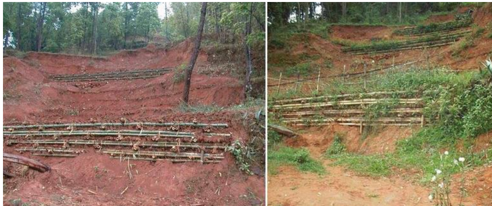
Slika 23: Potporna konstrukcija od bambusa [13]
