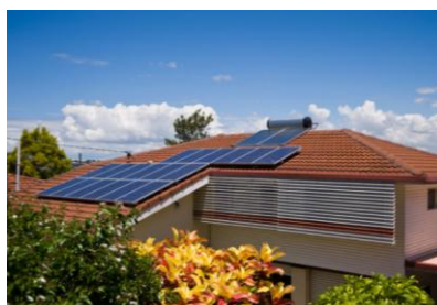
Slika 30. Solarni paneli na krovu kuće
