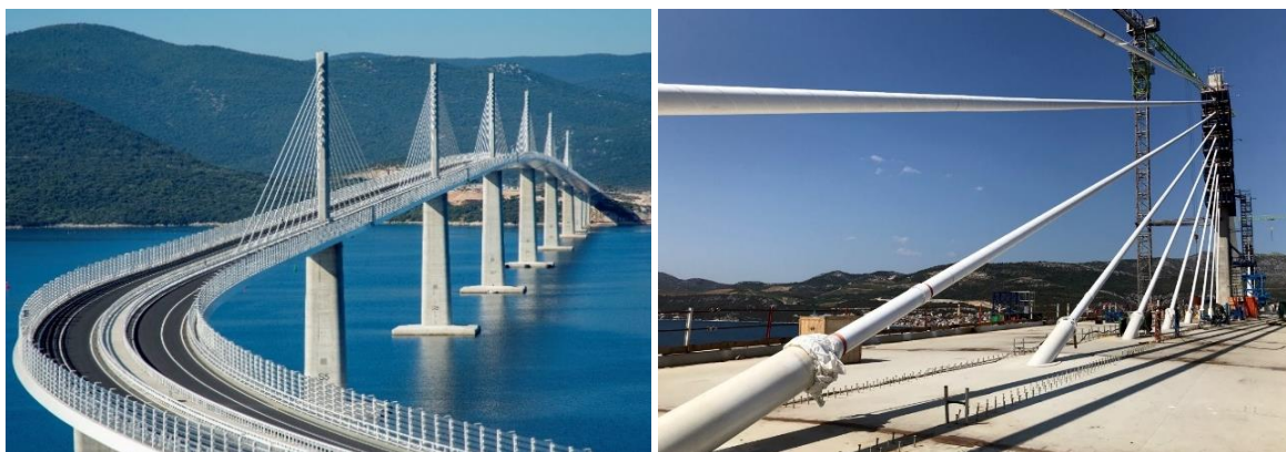
Slike 1;1a: Pelješki most; Kose zatege mosta [2]
