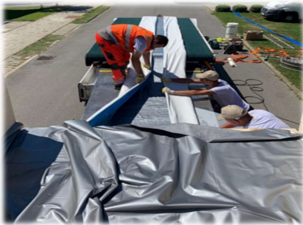
Slika 27 : Uvlačenje linera u okno pomoću konvejera [11]
