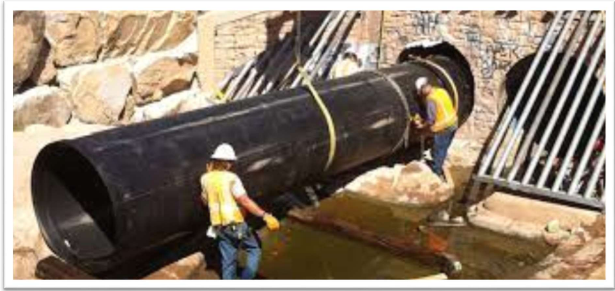
Slika 15 : Metoda klizajuće obloge [14]
