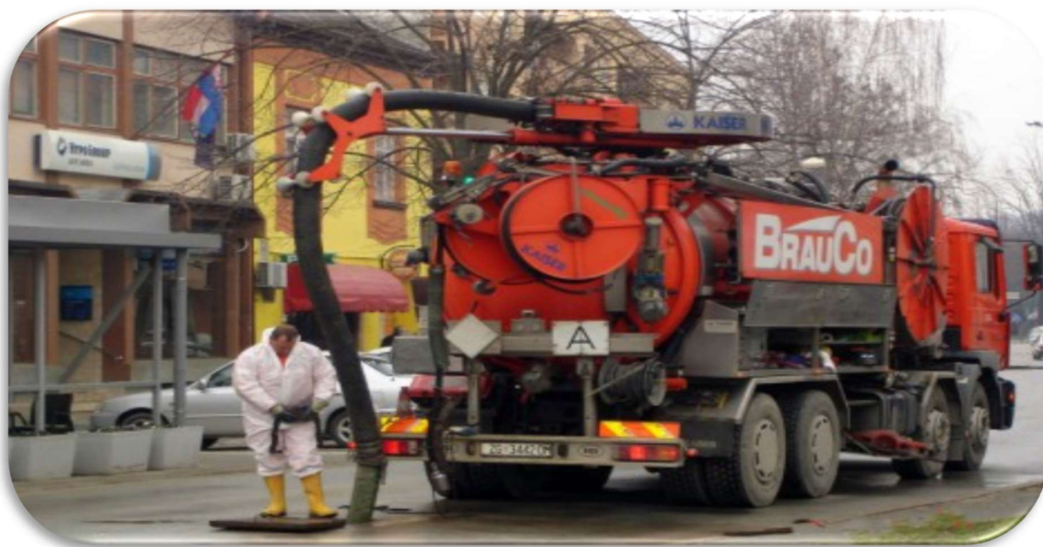
Slika 8 : Čišćenje kanalizacije [11]
