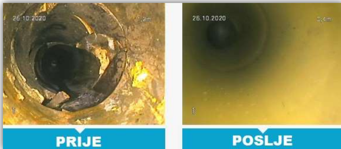
Slika 11 : Prije i poslije sanacije CIPP metodom [13]
