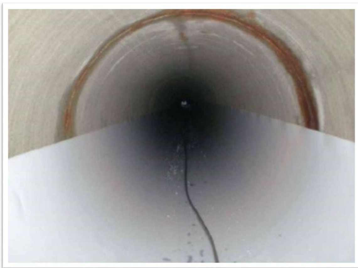
Slika 26 : Vodeća (gliding) folija za uvlačenje lineru [11]
