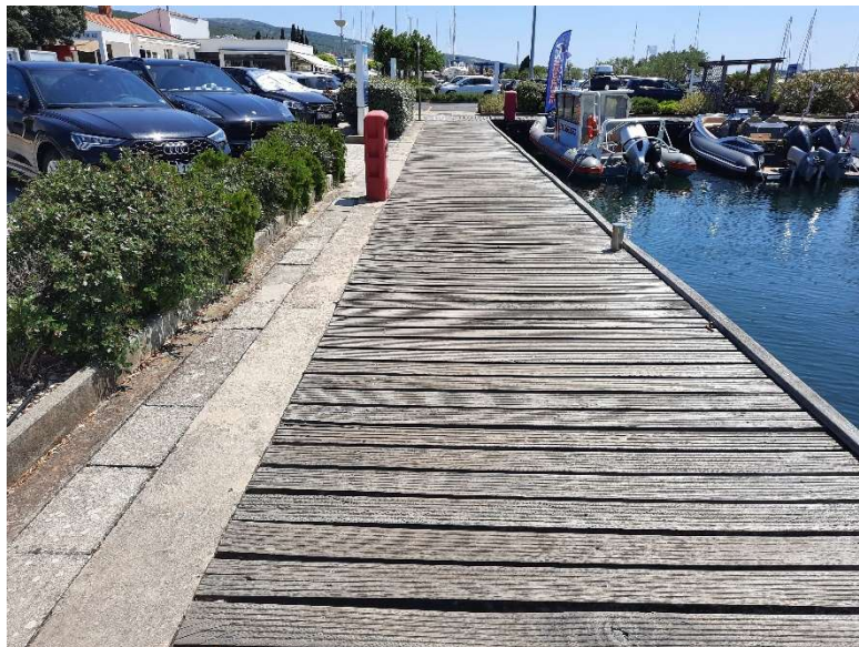
Slika 57: Fotografija prilazne rampe na gatu A6 (foto autor)
