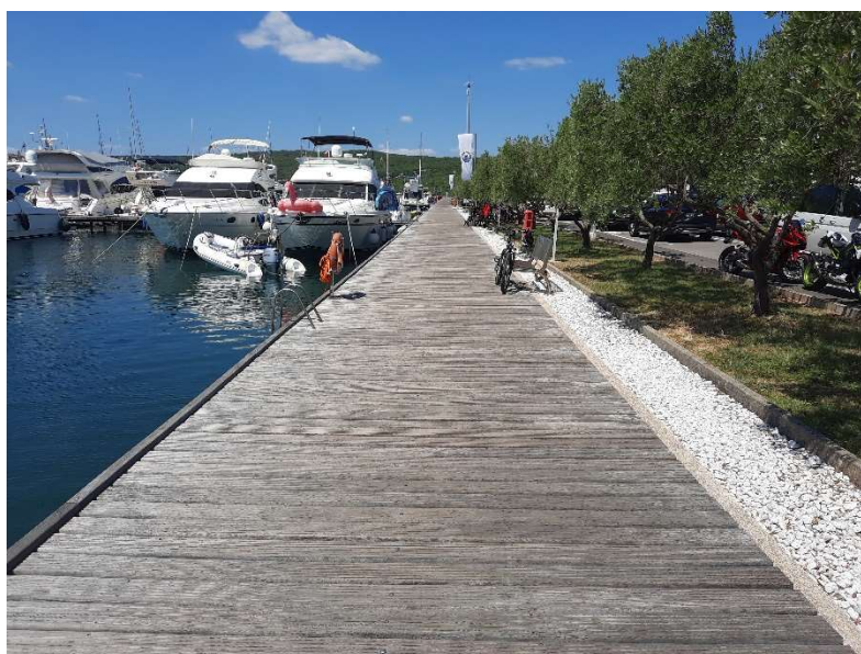
Slika 58: Fotografija prilazne rampe između gatova B4 i B5 (foto autor)
