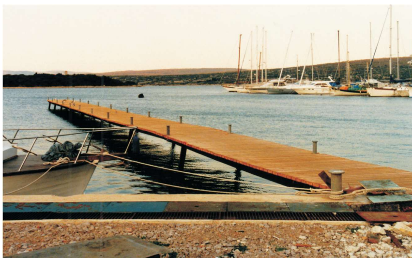
Slika 32: Prikazuje novi gat nakon rušenja gata na „garofulinama“ [2]
