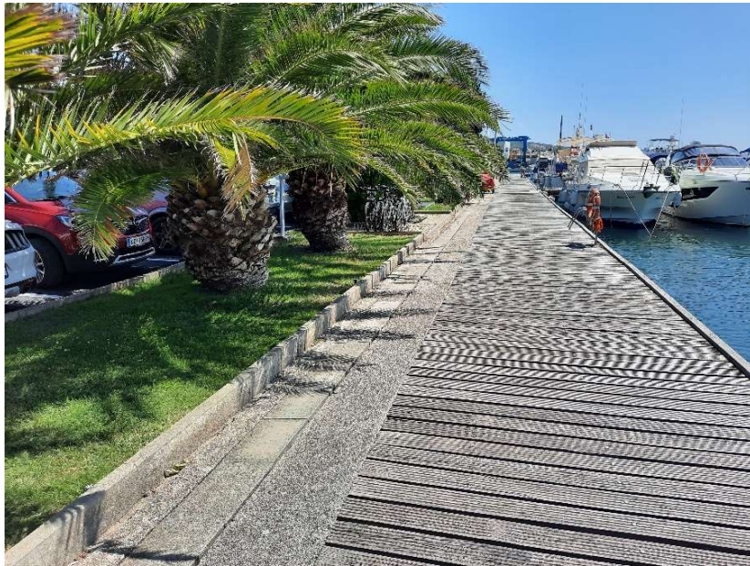
Slika 56: Fotografija Prilazne rampe između gatova A2 i A3 (foto autor)
