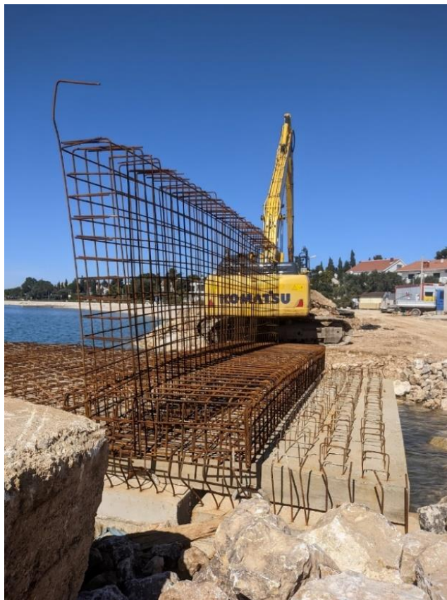
Slika 12. Armatura parapetnog zida (izvor: vlastita fotografija)
