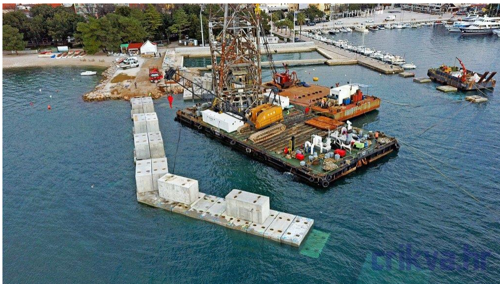
Slika 34: Izgradnja novog vertikalnog lukobrana u Crikvenici (Izvor: https://www.crikva.hr , pristup 25.4.2023.)
