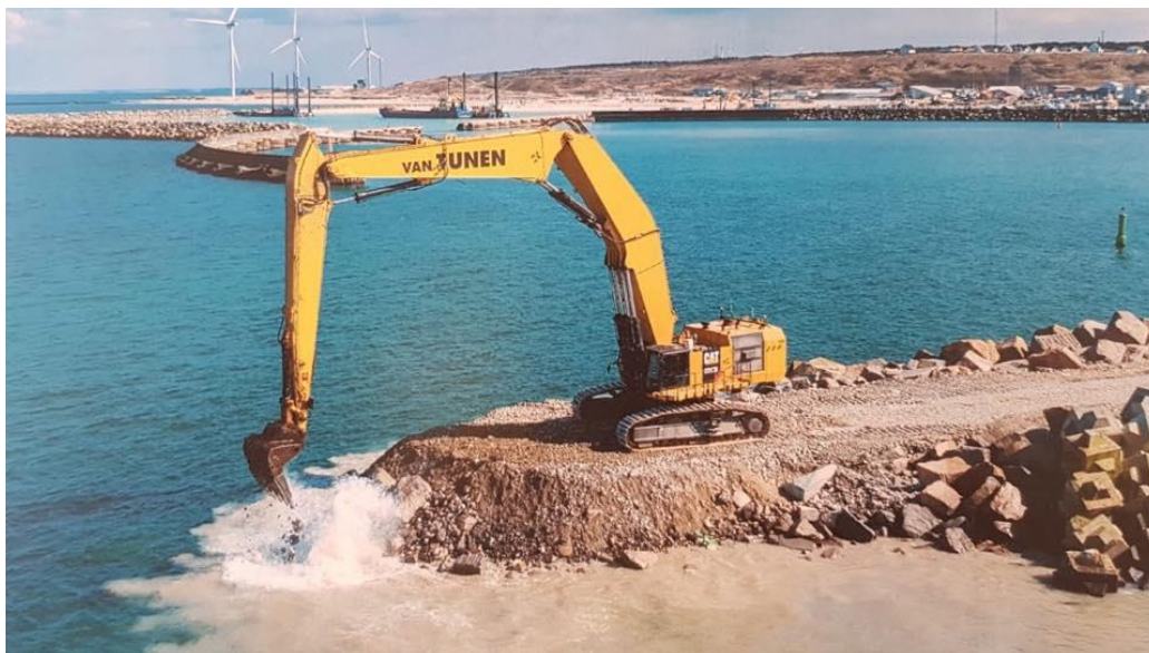
Slika 28: Nasipavanje tijela lukobrana
