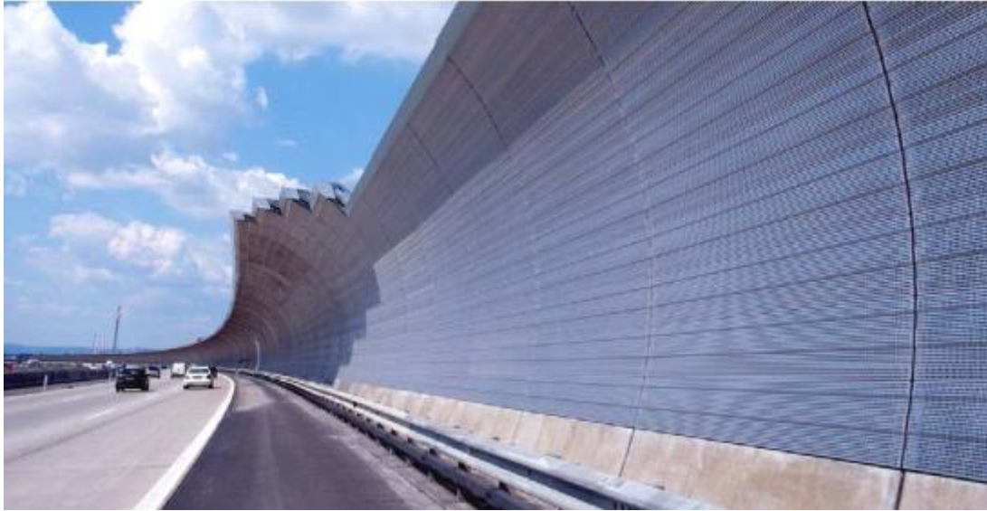
Slika 17: Savijena čelična zvučna barijera
