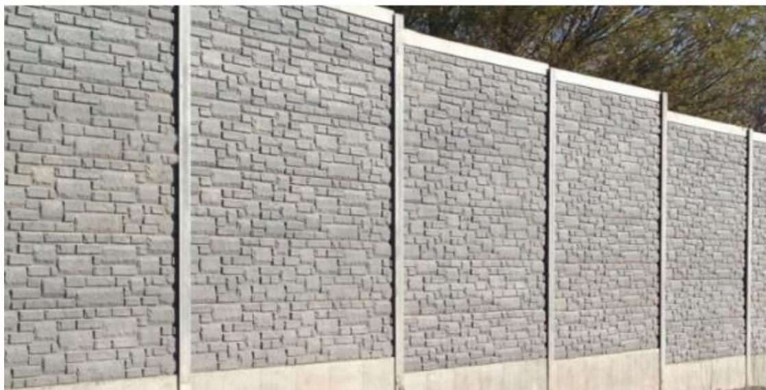
Slika 16: Betonske zvučne barijere
