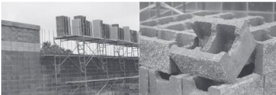
Slika 20: Zidane zvučne barijere [21]
