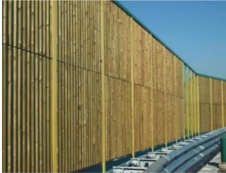
Slika 19: Drvene zvučne barijere
