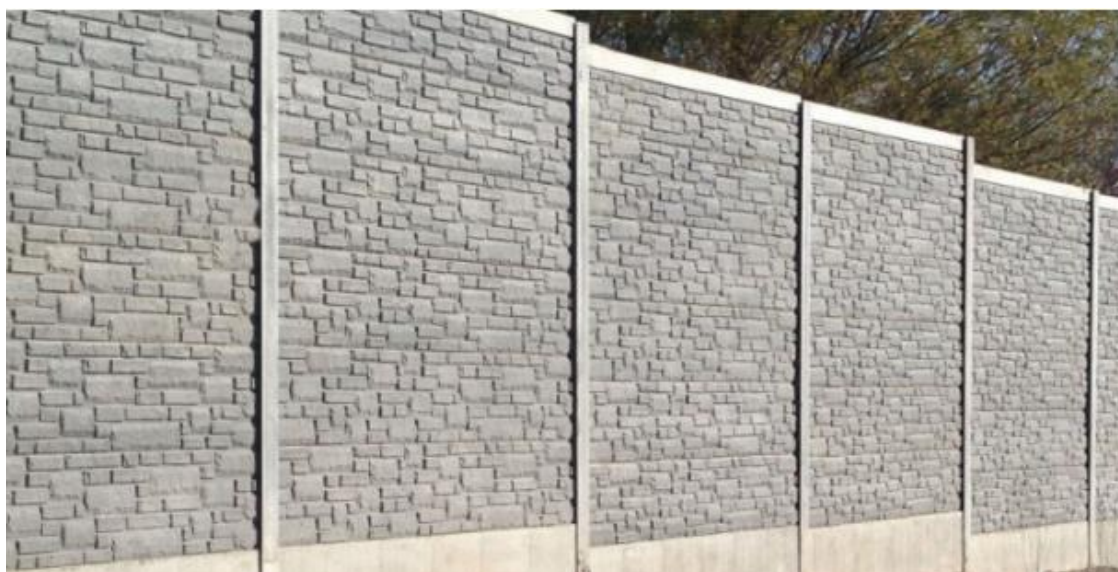
Slika 16: Betonske zvučne barijere
