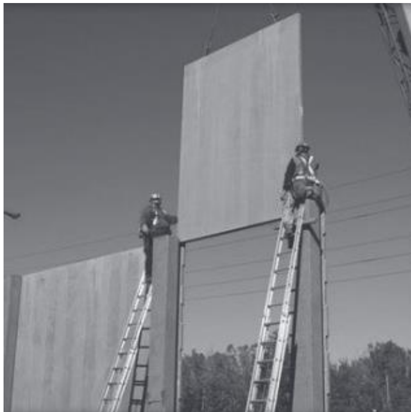
Slika 21: Predgotovljeni samostojeći bukobrani [21]
