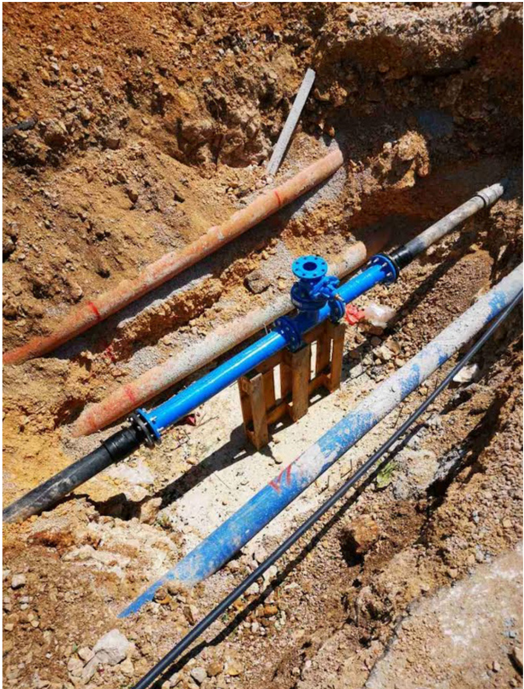
Slika 19. Tekući radovi na sustavu vodoopskrbe na dionici Privlaka (Marko Dujić)
