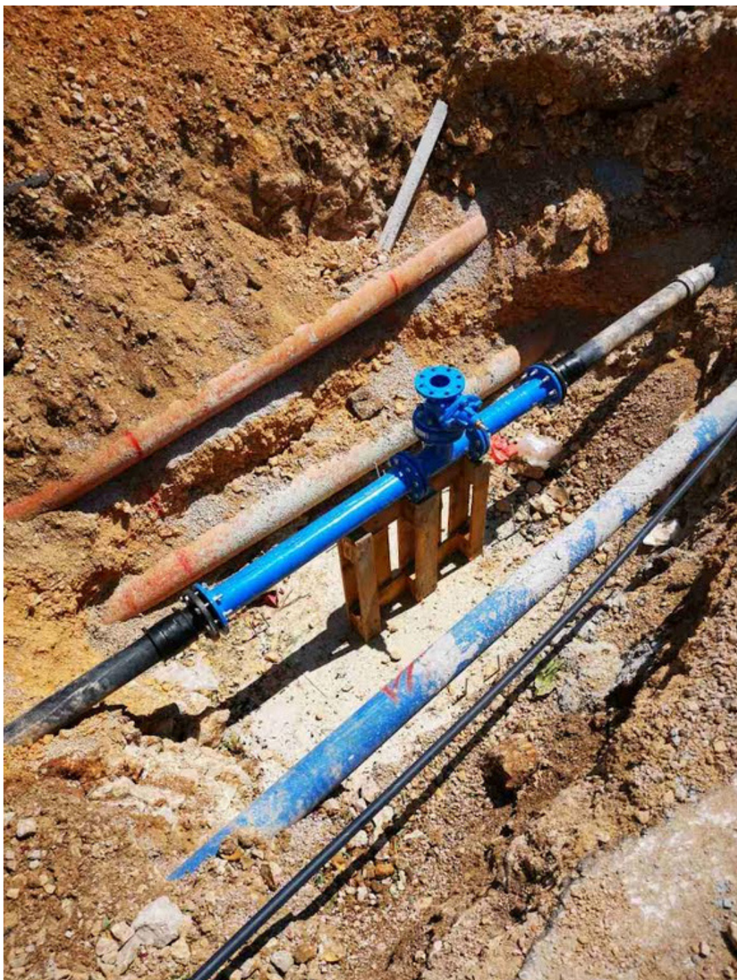
Slika 19. Tekući radovi na sustavu vodoopskrbe na dionici Privlaka (Marko Dujić)
