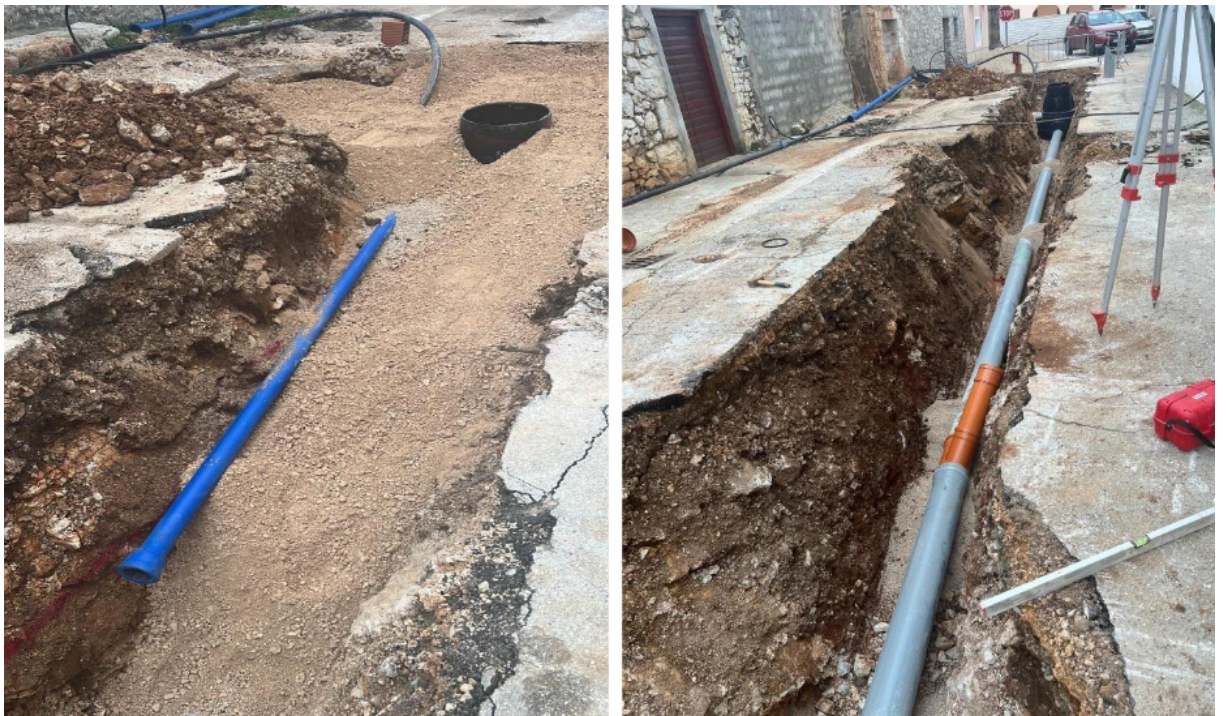
Slika 25. Polaganje vodovodnih cijevi u Zatonu (Marko Dujić)
