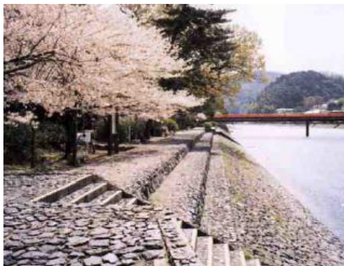
Slika 17: Oblaganje obale u skladu s krajolikom na rijeci Uji [21]
