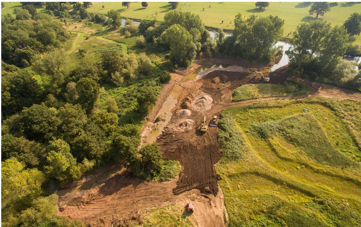
Slika 14: Izvođenje novog kanala kojim se Cherry Holme povezuje s rijekom Trent [19]
