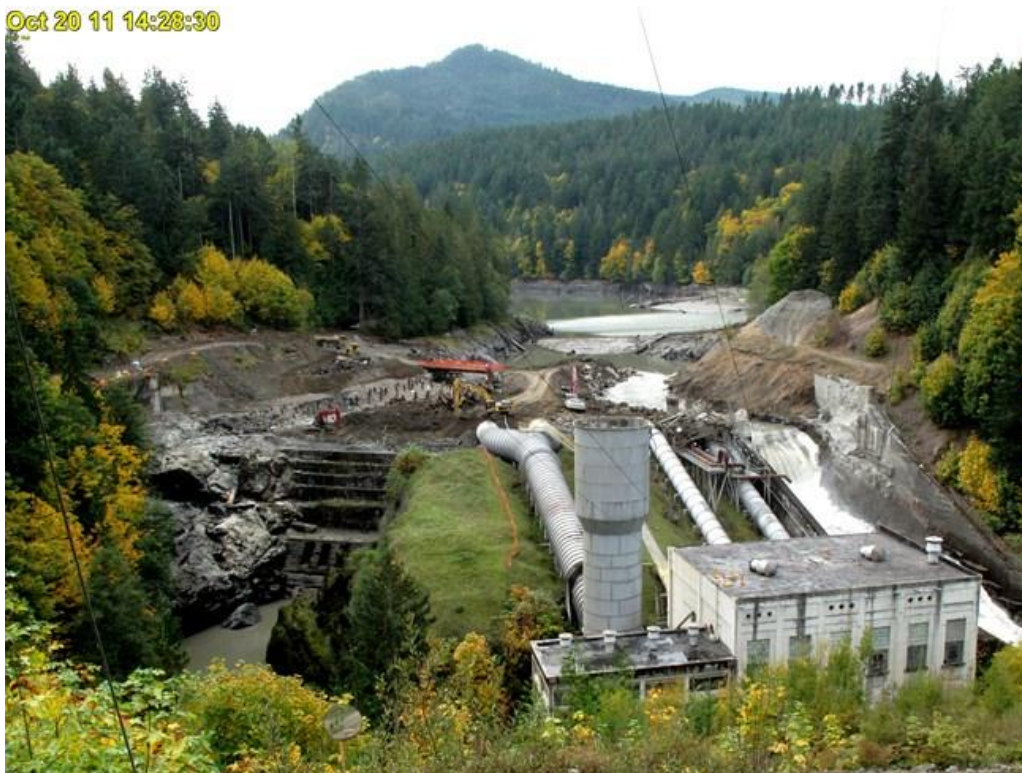
Slika 28: Uklanjanje brane Elwha [36]
