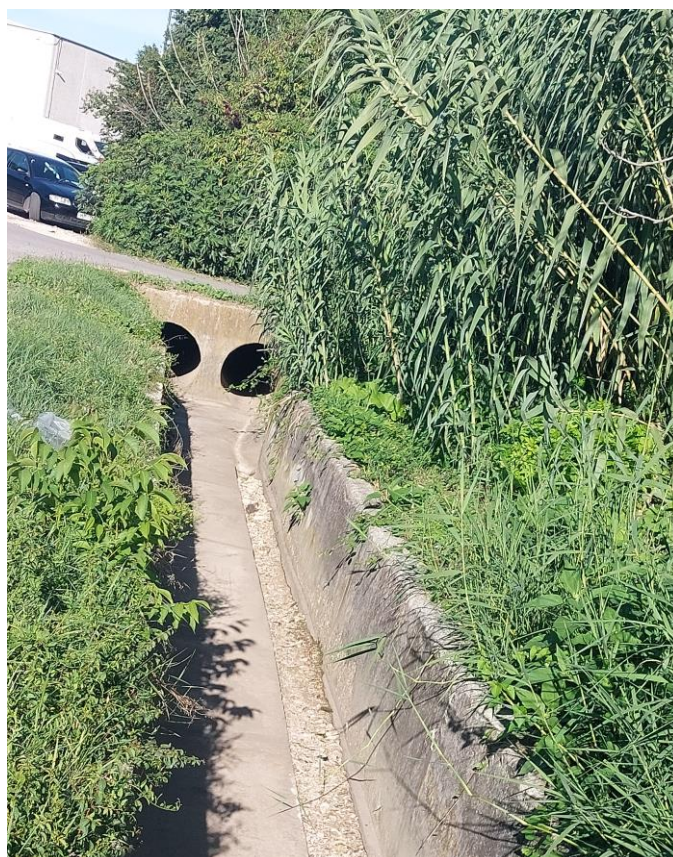
Slika 80: Odvodni kanal na kraju obuhvata [fotografija: autor, 15.07.2023.]
