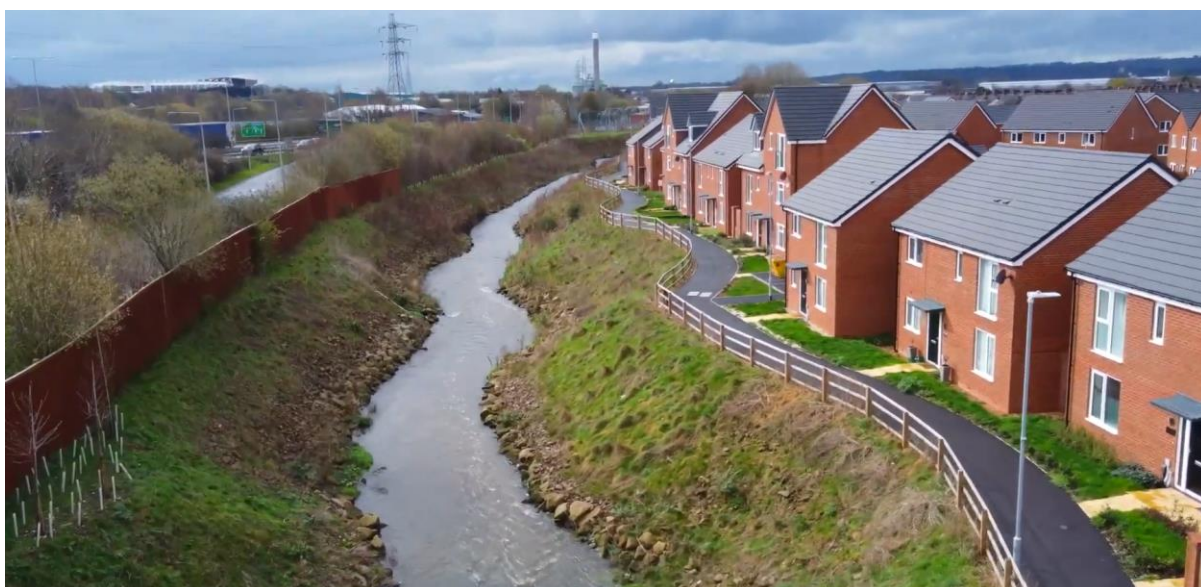
Slika 12: Stanje nakon uklanjanja betonskog kanala i izvođenja prirodnog toka rijeke [18]
