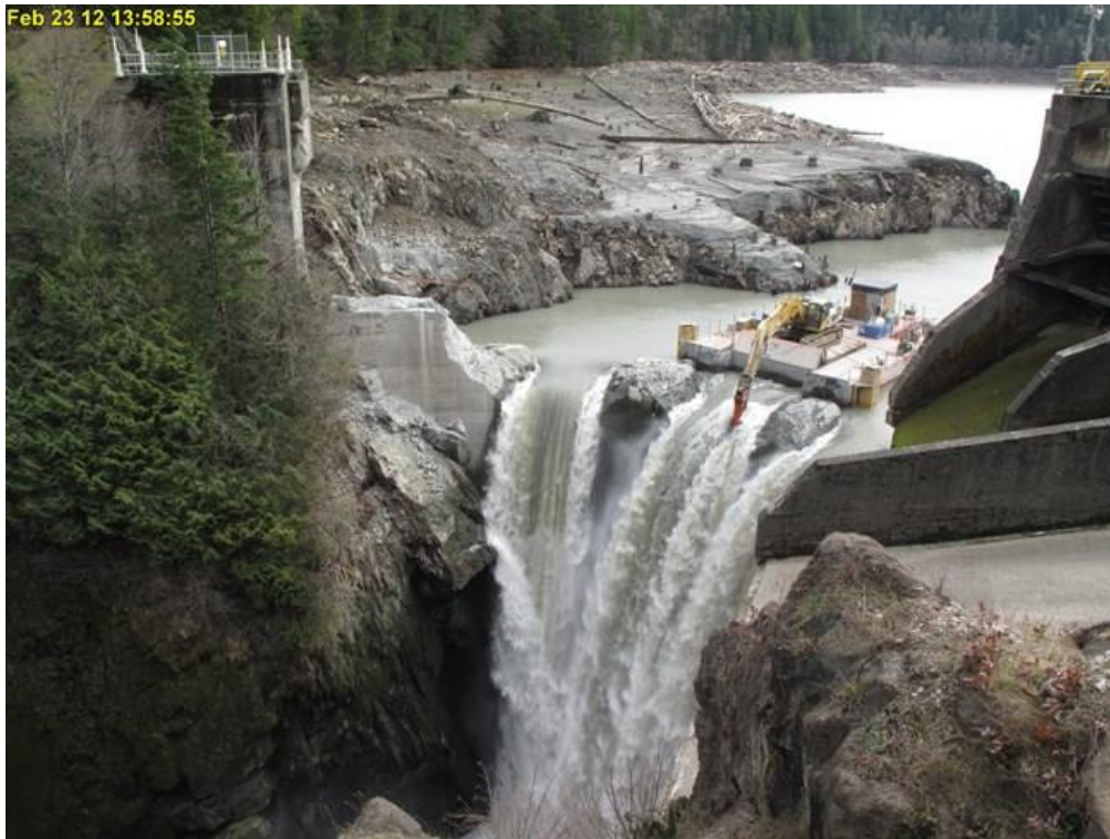
Slika 27: Uklanjanje brane kanjona Glines [36]
