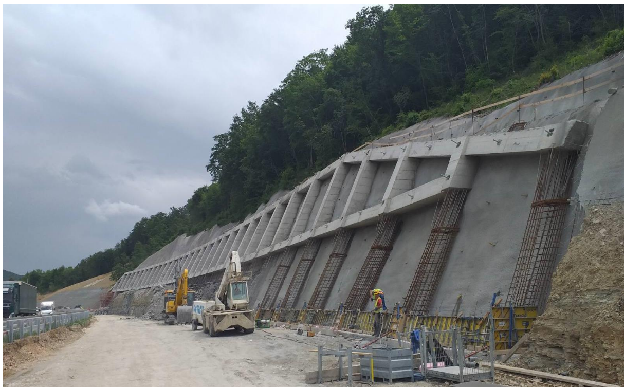
Slika 27. Roštiljna konstrukcija u fazi izvođenja, Istarski ipsilon
