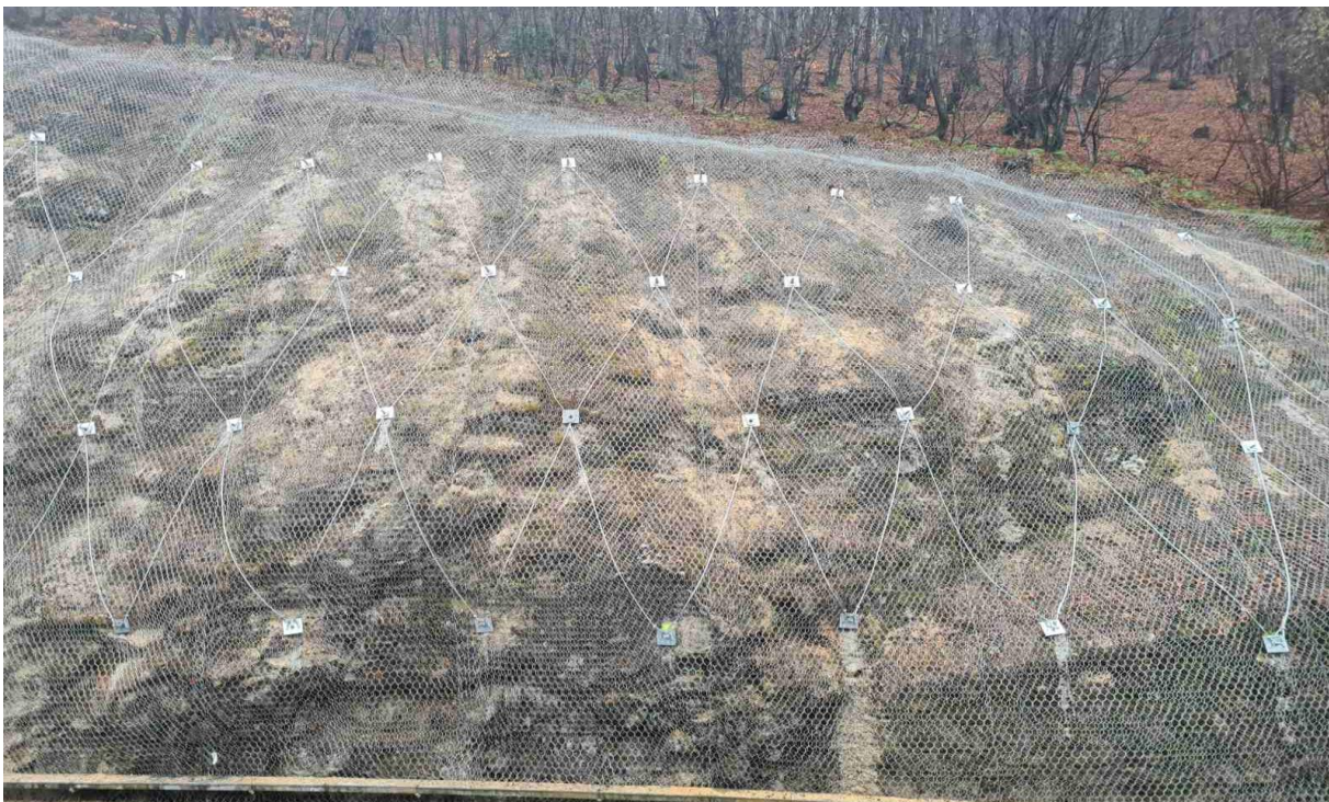
Slika 14. Kabelska nosiva mreža sa sekundarnom heksagonalnom mrežom
