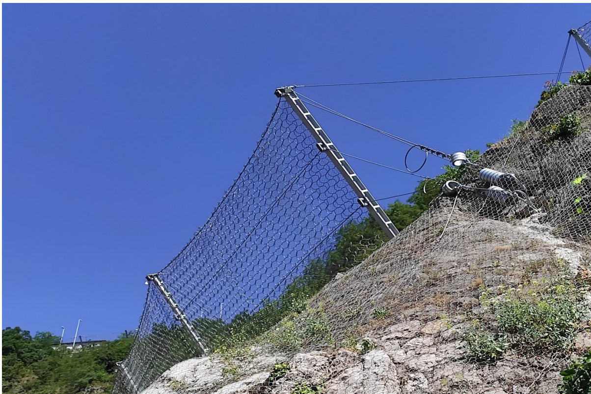
Slika 19. Barijera za zaštitu od odrona
