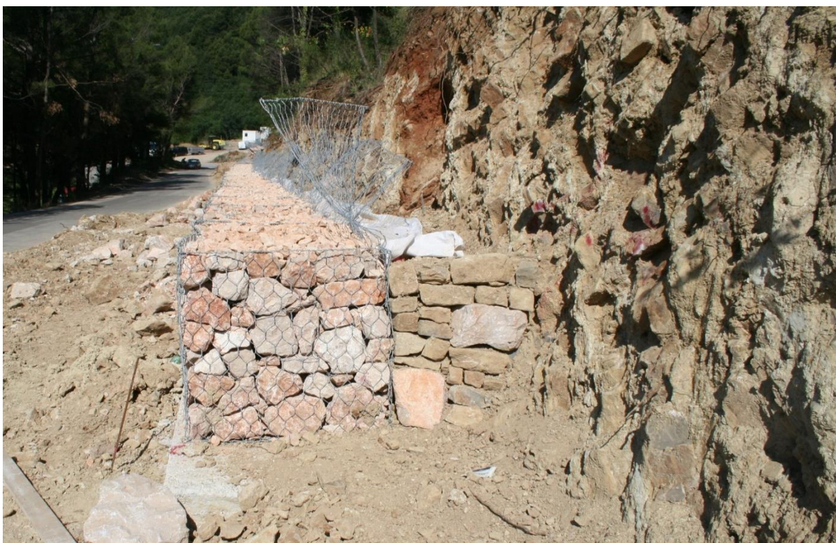
Slika 23. Punjenje gabionskih koševa kamenim materijalom
