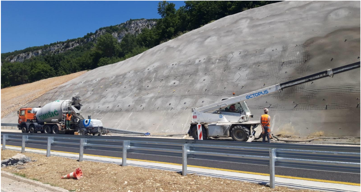
Slika 34. Automiješalica, pumpa za mlazni beton i manipulator
