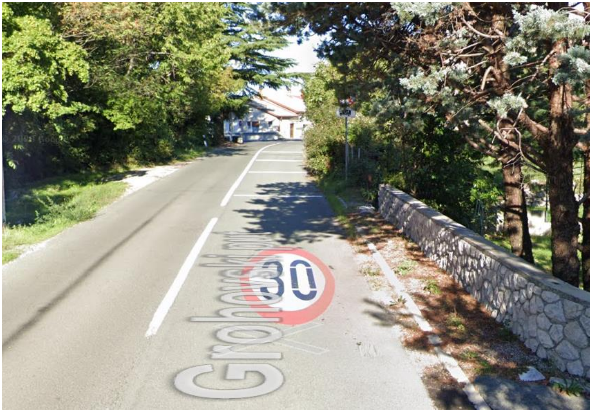
Slika 40. Znakovi na kolniku za smirivanje prometa ( https://www.google.com/maps/ )
