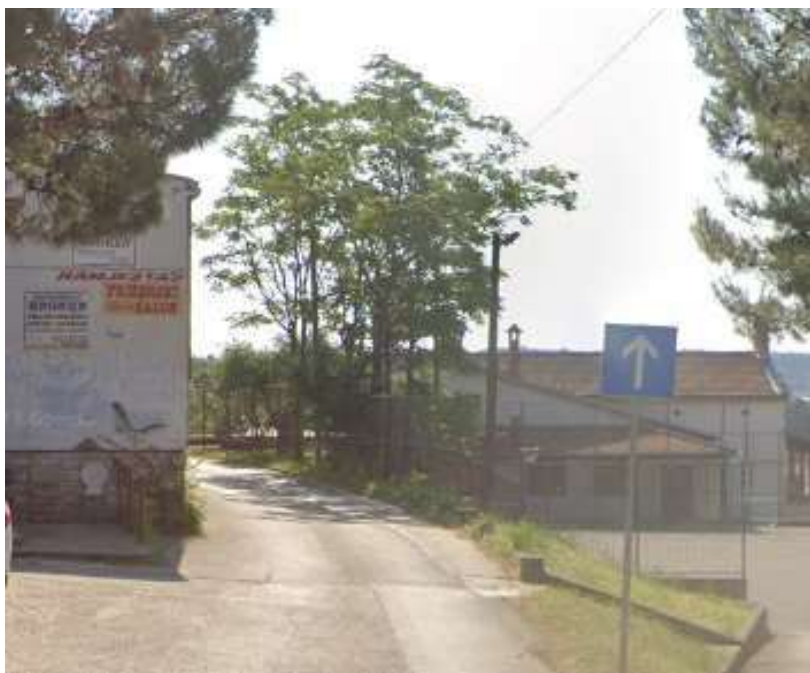
Slika 56. Pogled na neuređenu prometnicu[16]
