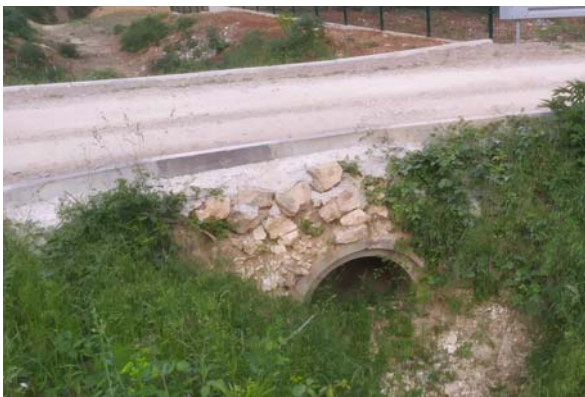
Slika 47. Cestovni propust (pc1)
