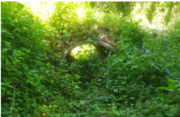
Slika 18. propust ispod ceste (pc1)
