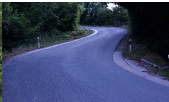
Slika 127. Cestovni propust (pc1)
