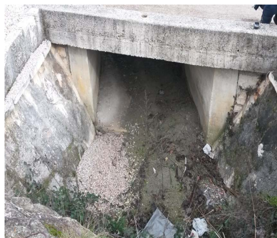
Slika 160. Cestovni propust (pc1)
