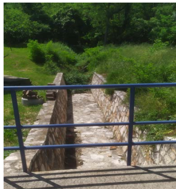
Slika 24. Kanal od kamena u betonu
