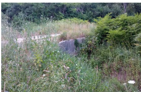
Slika 69. cestovni propust (pr1)
