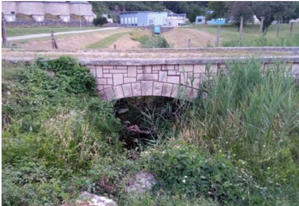
Slika 40. Cestovi propust (pc2)
