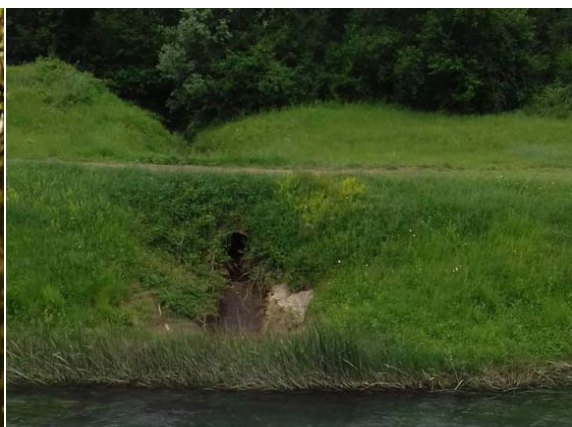
Slika 111. Cestovni propust (pc1)
