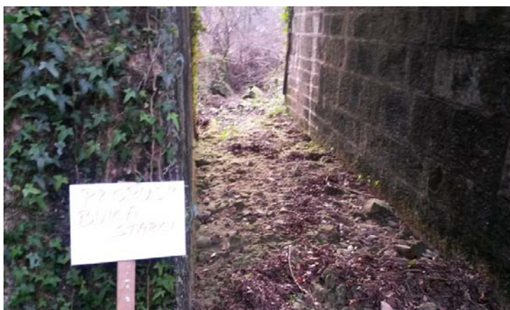
Slika 174. Gornji tok – cestovni propust (pc1)
