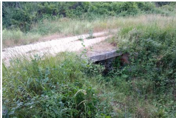
Slika 61. Cestovni propust (pc1)
