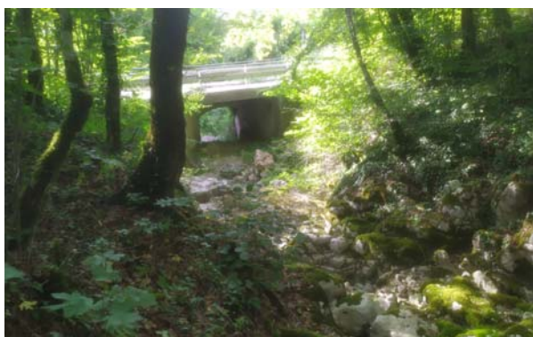
Slika 128. Cestovni propust (pc2)
