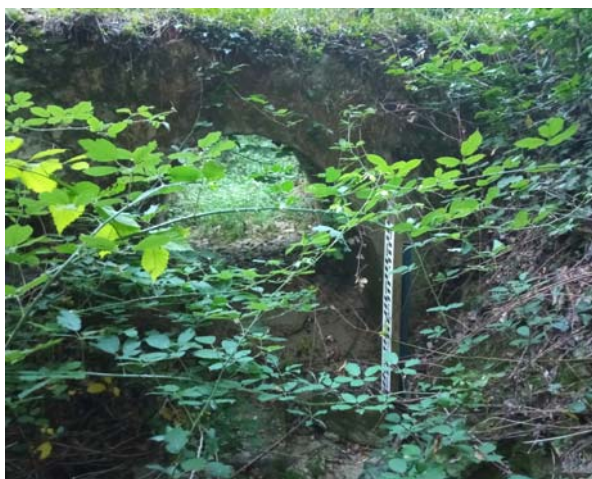
Slika 76. Cestovni propust (pc1)
