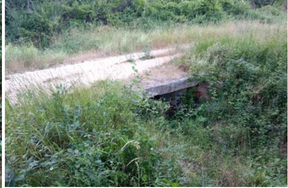
Slika 61. Cestovni propust (pc1)
