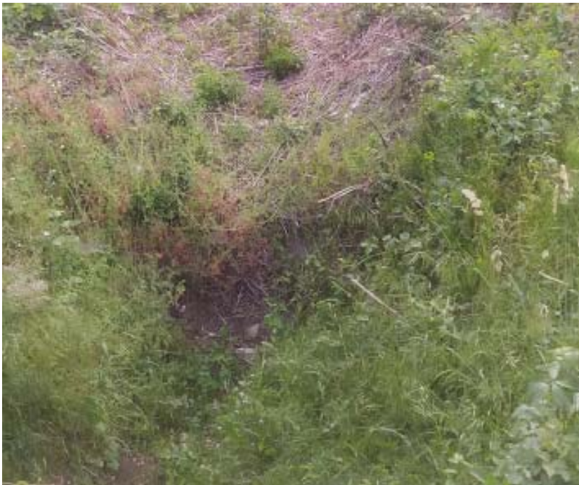
Slika 97. Utok u kanal
