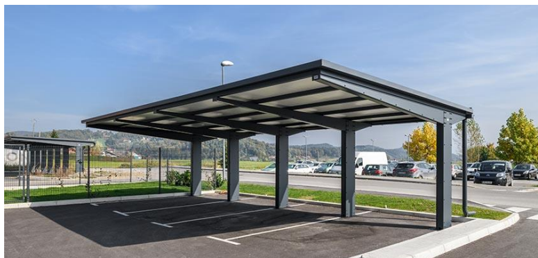
Slika 2. Primjer metalne nadstrešnice. [4]
