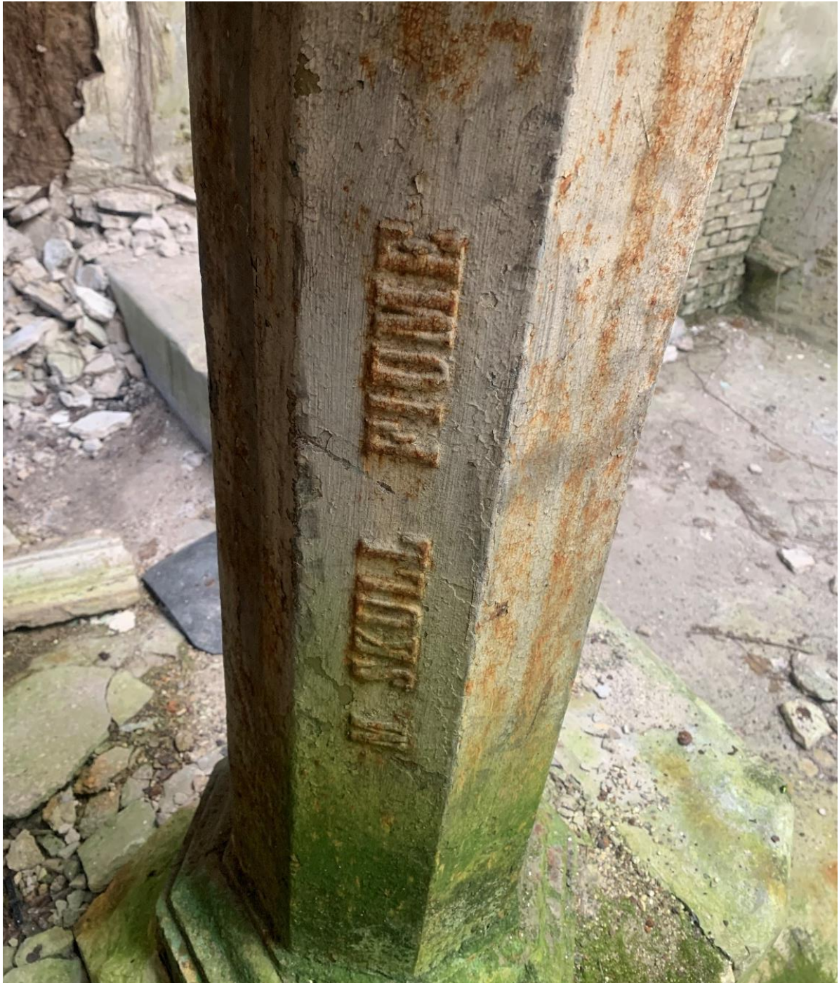
Slika 5: Ljevanoželjezni stup iz radionice Mattea Skulla
