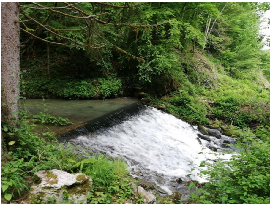
Slika 6 Postojeće stanje vodotoka
