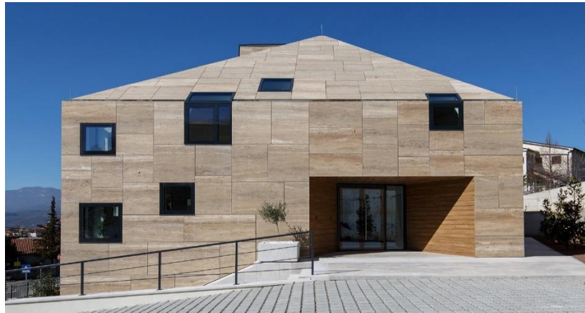
Grafički izvor 4. Primjer građevine sa ventiliranom fasadom i kamenom oblogom
