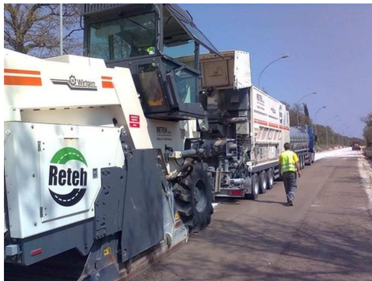
Slika 14: Vlak s više jedinica na gradilištu [8]
