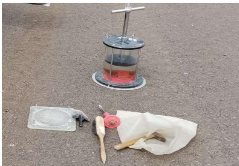
Slika 25. Utvrđivanje stupnja zbijenosti volumetrom
