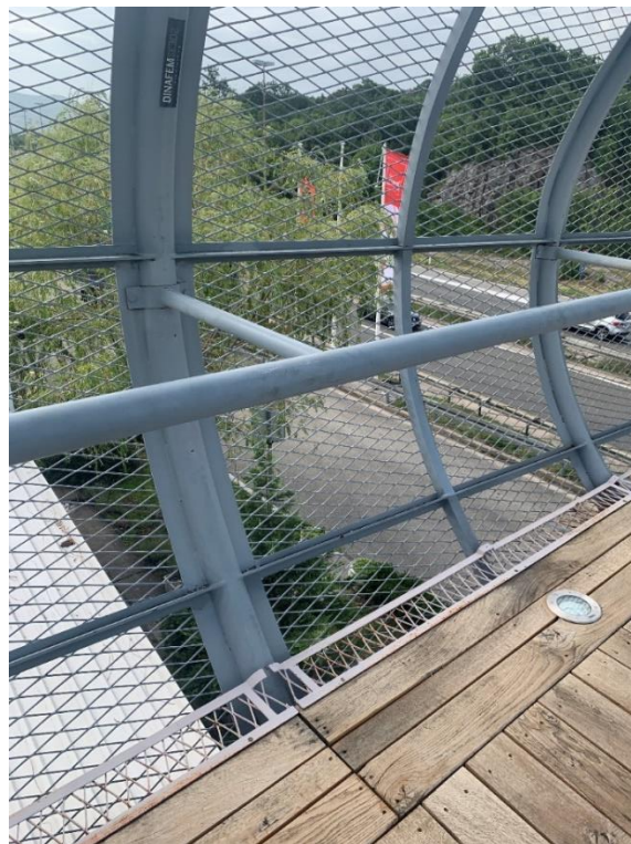
Slika 47: Ograda i rukohvat mosta Vrata Jadrana
