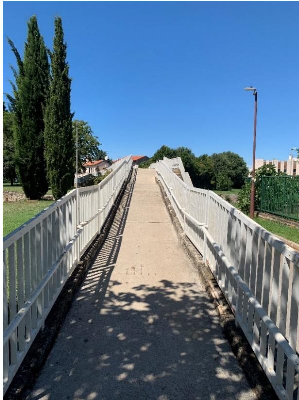
Slika 74: Rampa mosta u Prvomajskoj ulici
