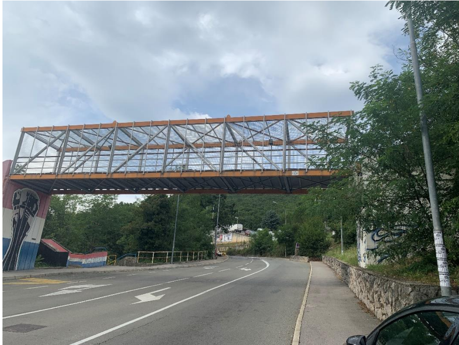
Slika 49: Konstrukcija mosta iznad Škurinjske Ceste
