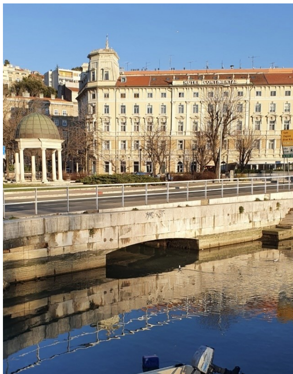
Slika 7 - Ušće potoka iz Vodovodne [1]
