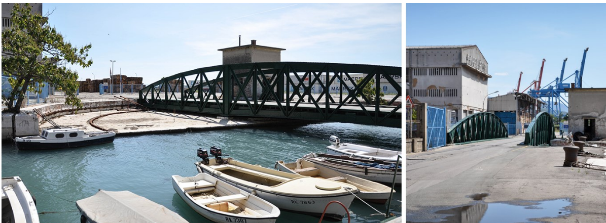
Slika 23 - Zakretni most (izvor: https://rijekaheritage.org/hr/kj/zakretnimost# - 27.5.23.)
