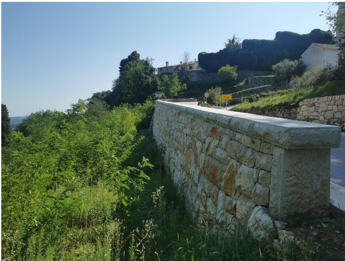
Slika 19 Potporni zid s gornje strane klizišta (foto: L.Vuksan, kolovoz 2023)
