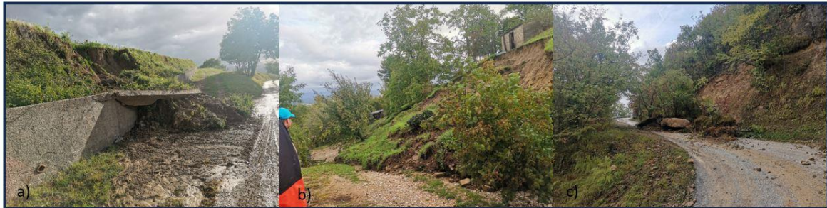
Slika 12 a) b) i c) translacijsko klizanje površinskih naslaga
