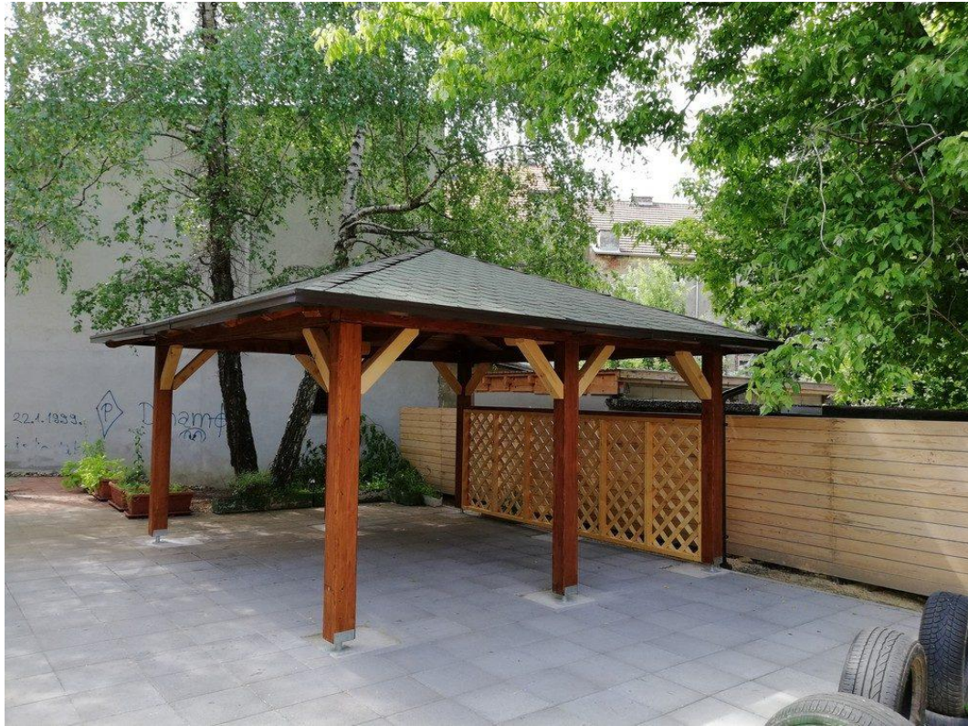
Slika 8. Primjer šatoraste nadstrešnice [17]
