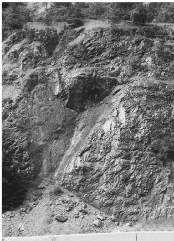
Slika 12. Tipični klinasti slom [2]
