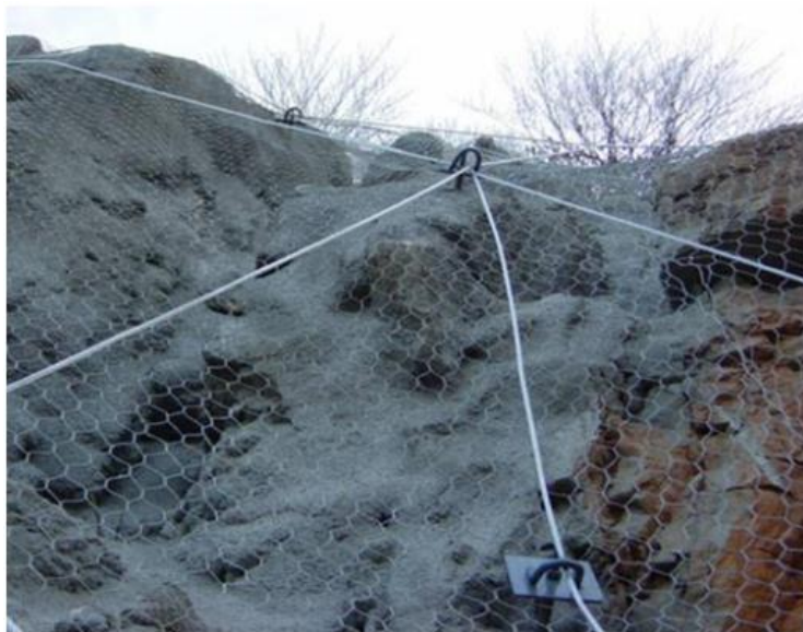
Slika 44. Zaštita pokosa pocinčanim mrežama koje su ojačane sidrima i čeličnom užadi [32]
