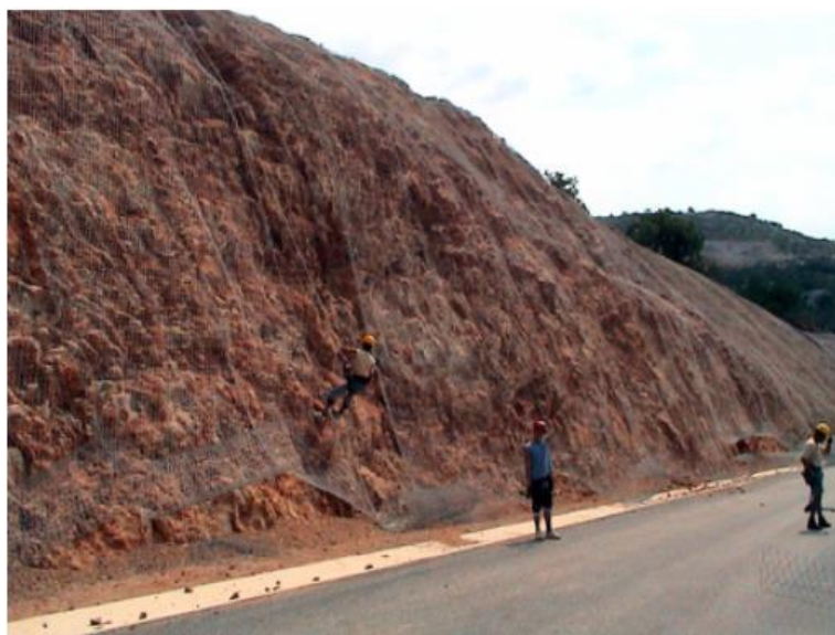
Slika 43. Zaštita pokosa dvostruko isprepletenim pocinčanim mrežama [32]
