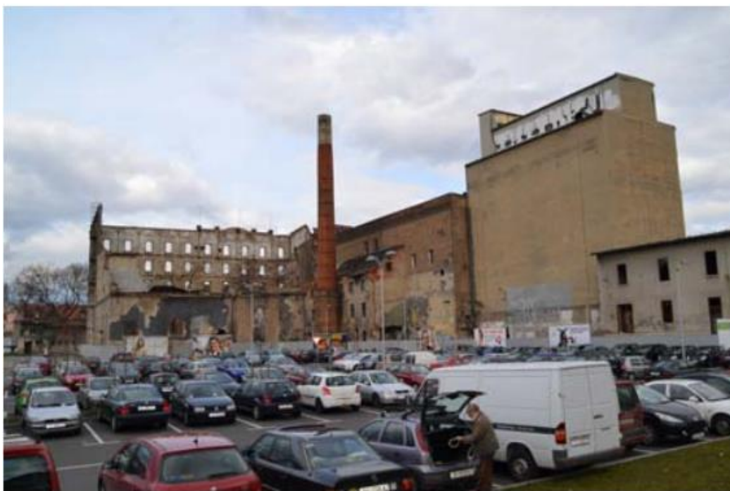
Slika 19: Postojeće stanje konstrukcije Paromlina [30]
