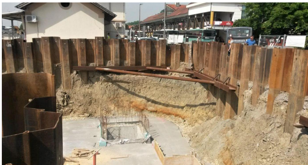
Slika 11: Dijagonalno postavljene razupore [17]
