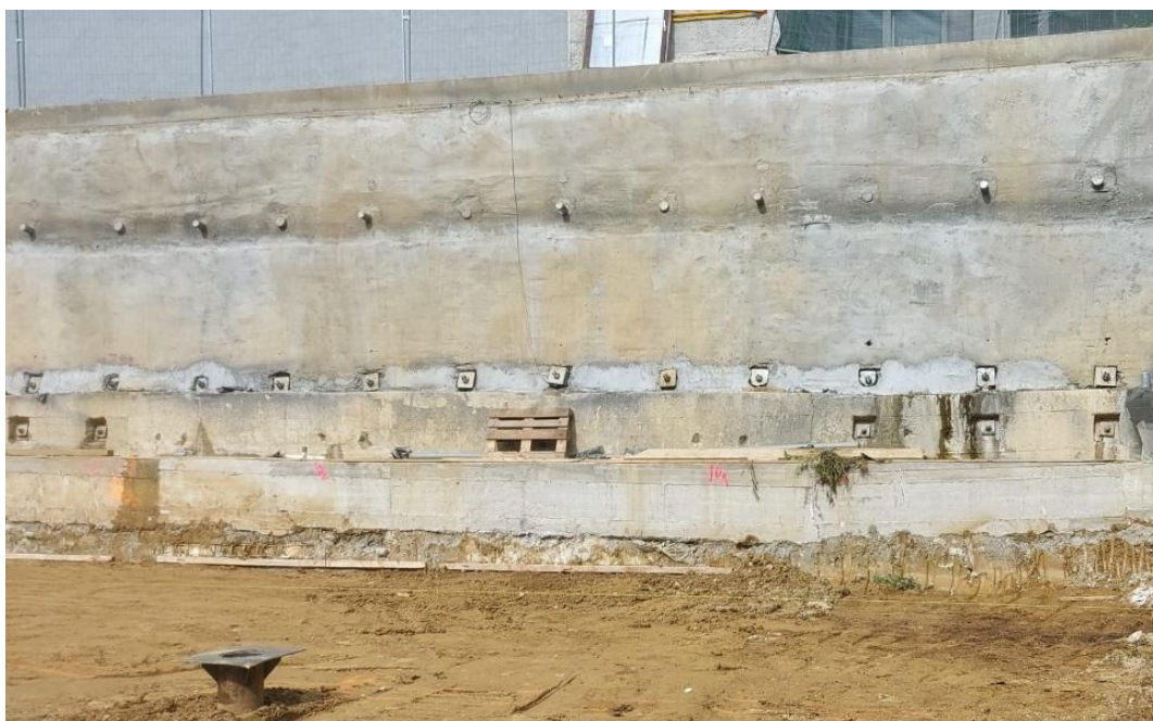
Slika 8: Armiranobetonska dijafragma [16]
