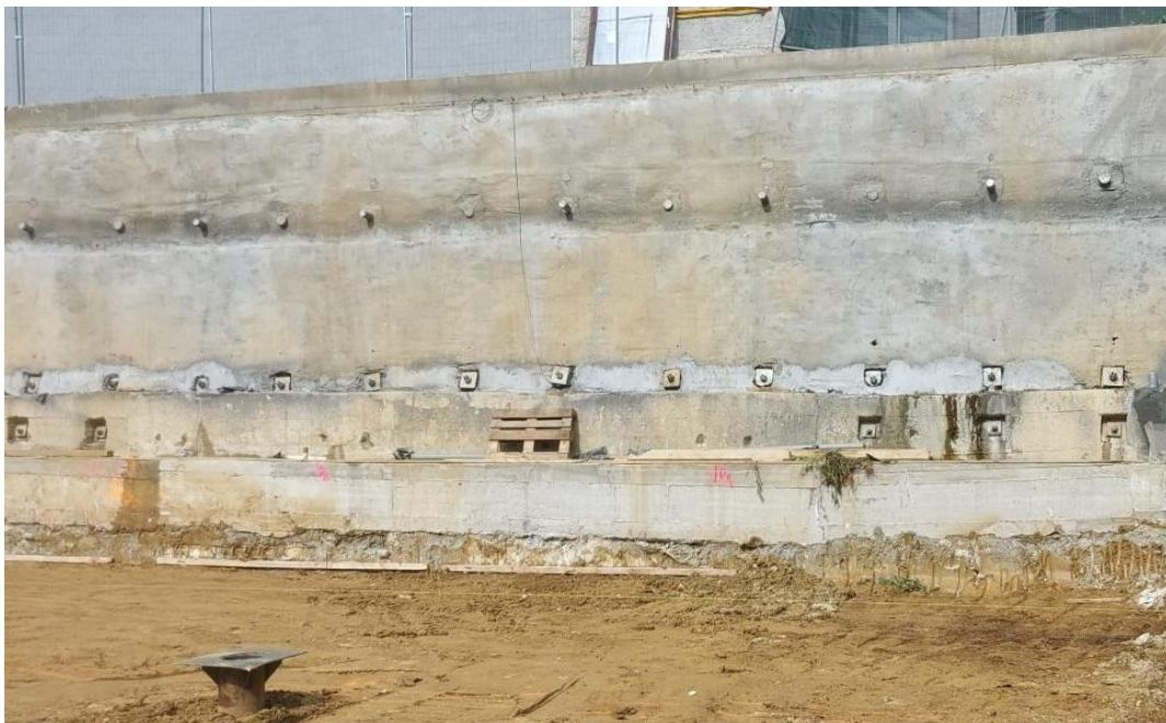
Slika 8: Armiranobetonska dijafragma [16]
