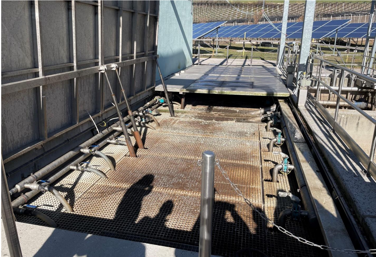
Slika 21. MBR bazeni (vlastita fotografija)
