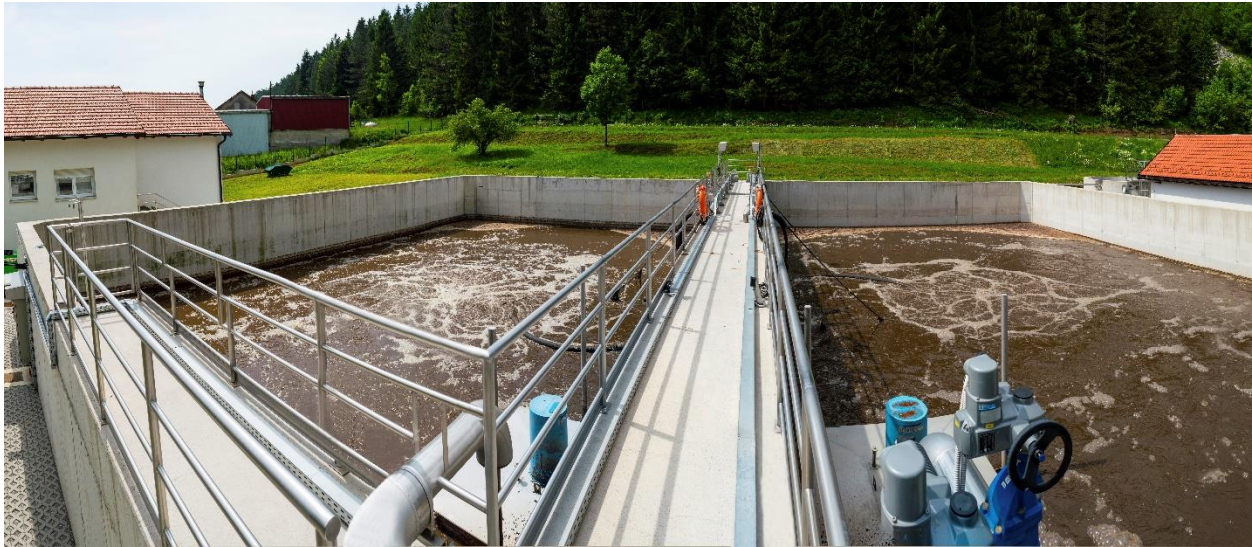
Slika 17. SBR reaktori (vlastita fotografija)
