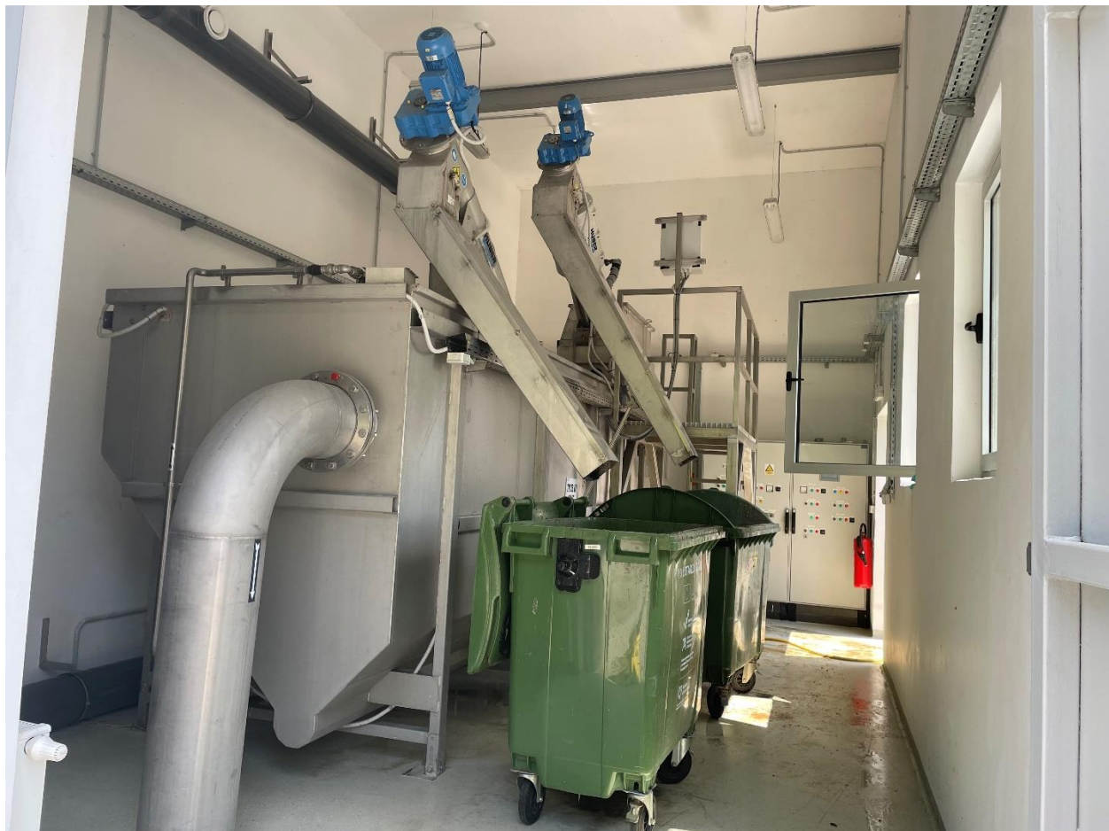
Slika 12. Kompaktni uređaj za mehaničku predobradu otpadnih voda (vlastita fotografija)
