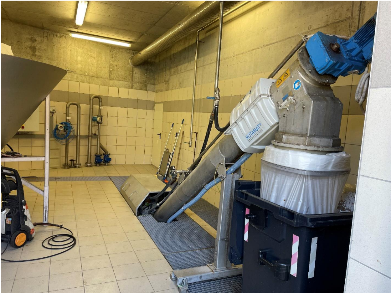
Slika 13. Fino sito (vlastita fotografija)
