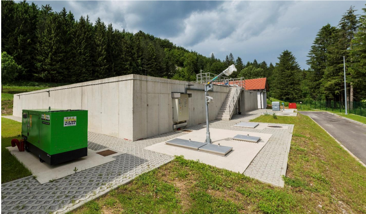
Slika 16. Crpna stanica ispred SBR reaktora (vlastita fotografija)
