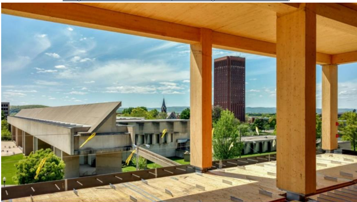
b) Međukatna konstrukcija s CLT pločama i HBV sustavom sprezanja (perforirane čelične ploče) prije betoniranja in situ (izvor: https://web.fpinnovations.ca/tcc/ )
