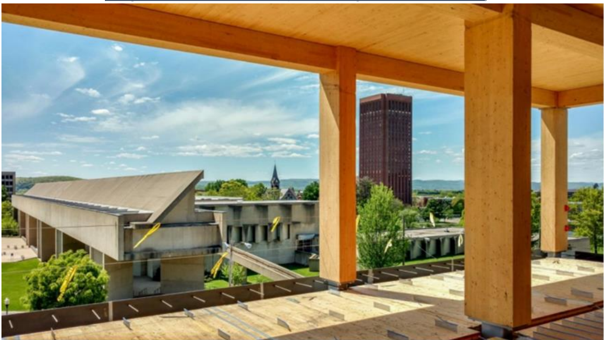
b) Međukatna konstrukcija s CLT pločama i HBV sustavom sprezanja (perforirane čelične ploče) prije betoniranja in situ (izvor: https://web.fpinnovations.ca/tcc/ )
