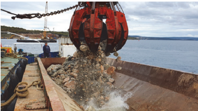
Slika 15. Utovar iskopanog materijala u klapetu [28]
