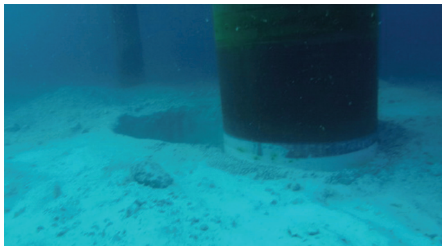
Slika 10. Iskop pomoću bušilice [28]
