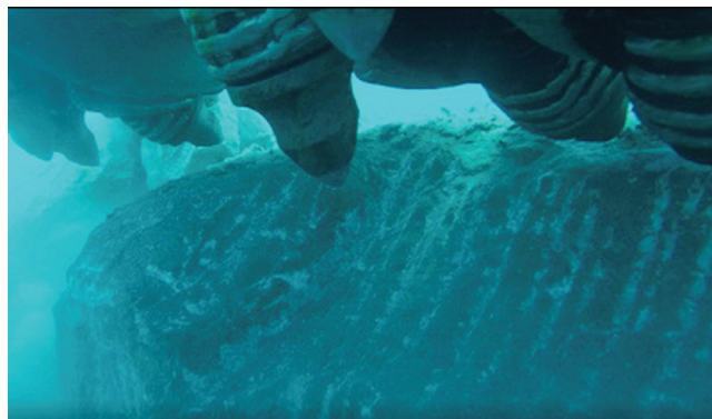
Slika 14. Nedovoljna učinkovitost iskopa pomoću hidrauličke glodalice [28]
