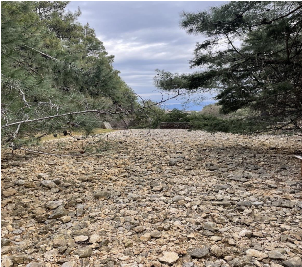
Slika 10: Nanos uzvodno od poprečnog objekta. (Slika autora 26.03.2023.)
