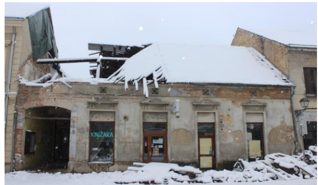
Slika 20. Urušavanje krova: shema [2], primjer nakon potresa u Petrinji [5]
