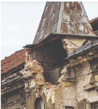
Slika 6. Slom ugla nakon potresa u Petrinji 2020.godine [8,10]
