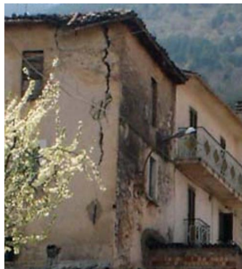
Slika 2. Prevrtanje zida pročelja: shema [2], primjeri [1]
