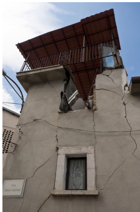
Slika 11. Prevrtanje vertikalne trake [10]
