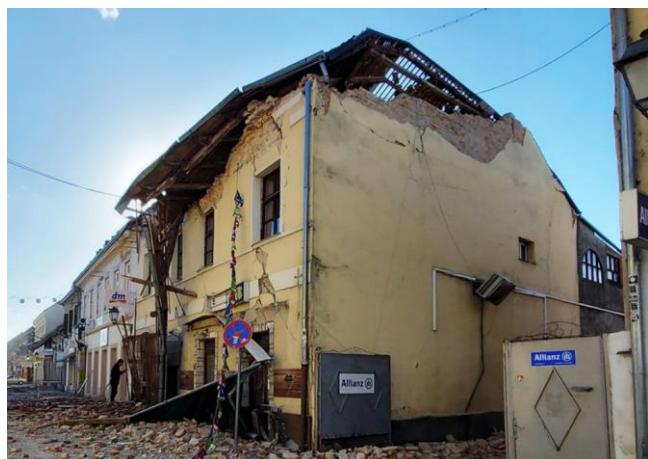
Slika 19. Prevrtanje lastavice zabata nakon potresa u Petrinji 2020.godine [9,12]
