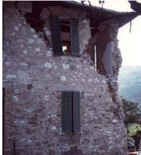
Slika 5. Slom ugla zida: shema [2], primjer [1]
