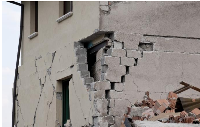
Slika 6. Slom ugla nakon potresa u Petrinji 2020.godine [8,10]
