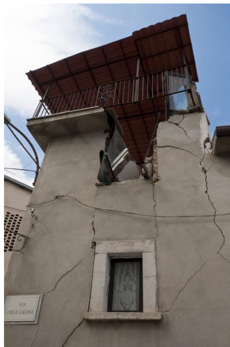
Slika 11. Prevrtanje vertikalne trake [10]
