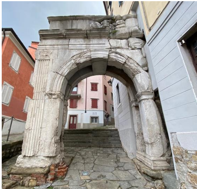
Slika 7: Arch of Riccardo, Italija – primjer luka sa 7 blokova [13]
