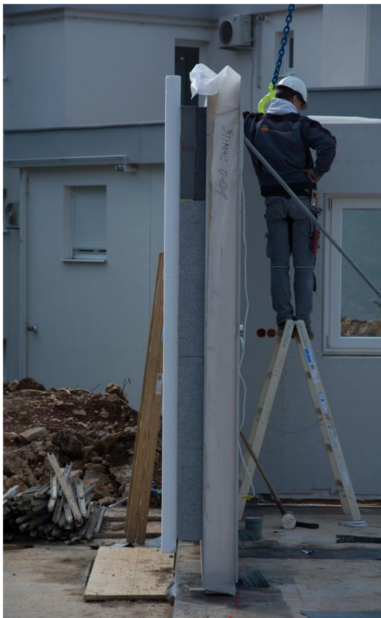
Slika 17 Poravnanje i provjera svakog panela – Slaganje u sustavu frame
