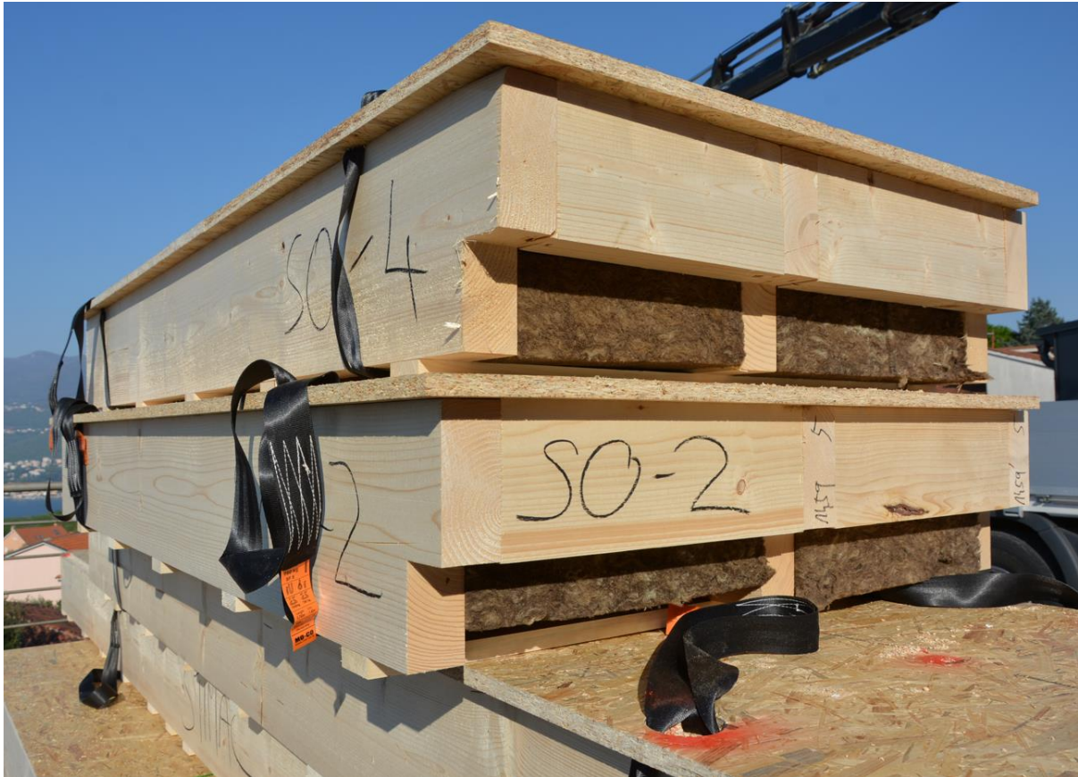
Slika 15 Dopremljeni paneli na gradilištu spremni za ugradnju – Slaganje u sustavu frame
