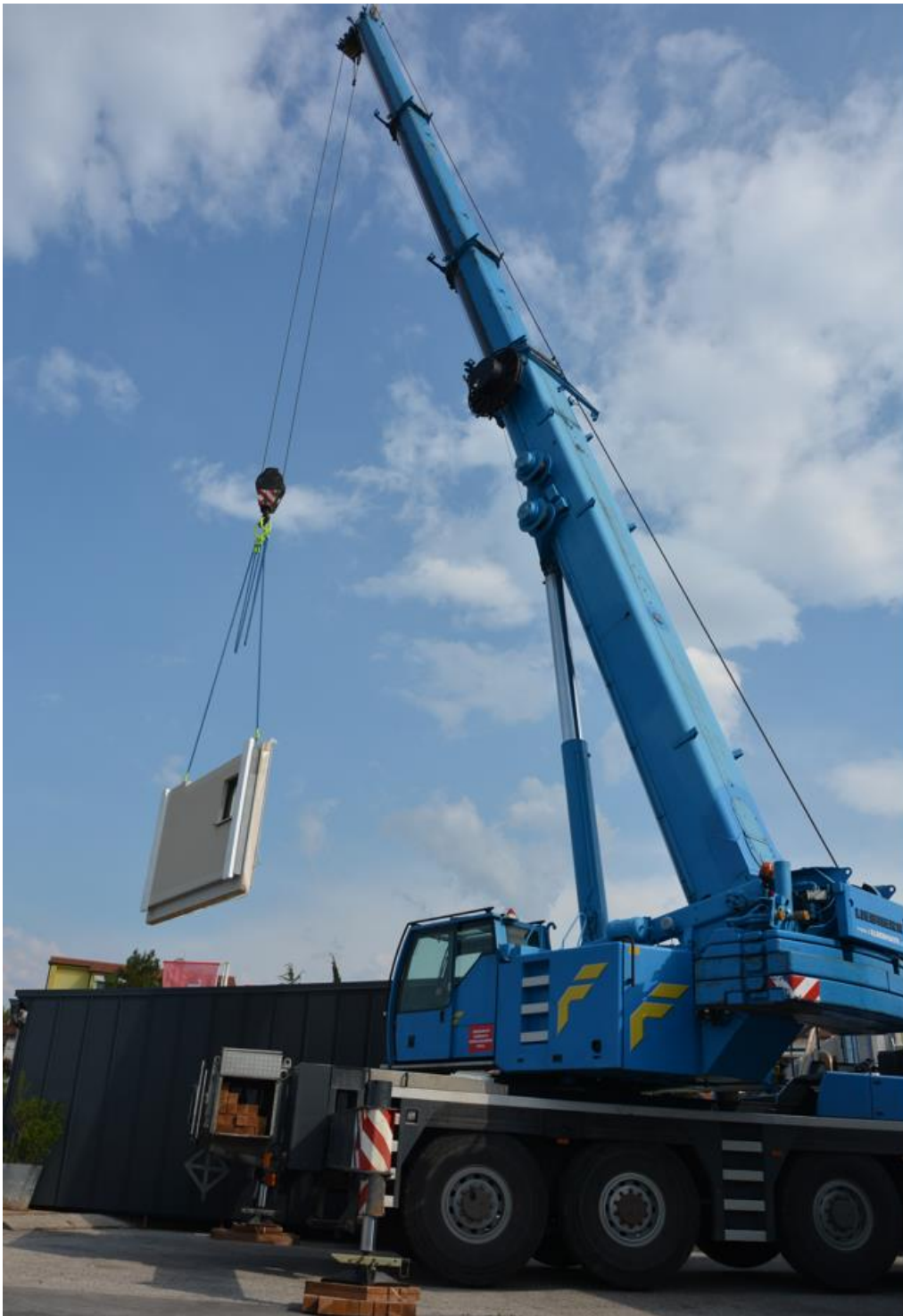
Slika 6 Podizanje panela - Slaganje u sistemu frame
