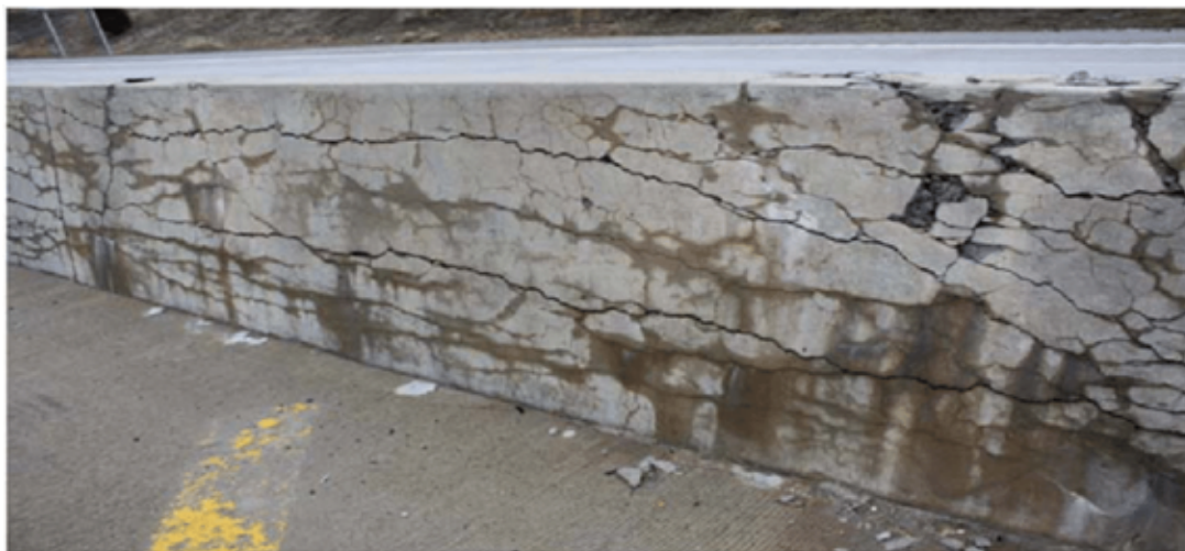
Slika 5: Barijera na autocesti napadnuta alkalnom reakcijom [6]
