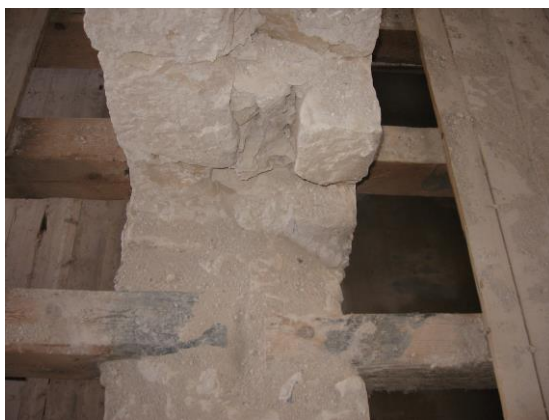
Slika 30: Oslonac drvenog grednika na kamenu zid (osobna arhiva, 2009.)
