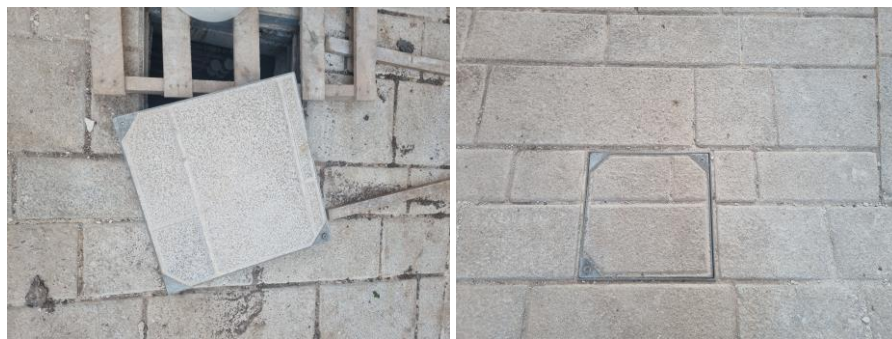
Slika 45: Izvedba poklopacu u gradskoj jezgri, Bale-Valle (foto autorica, 2023.)
