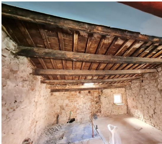
Slika 29: Tradicijska drvena međukatna konstrukcija, Rovinj 188
