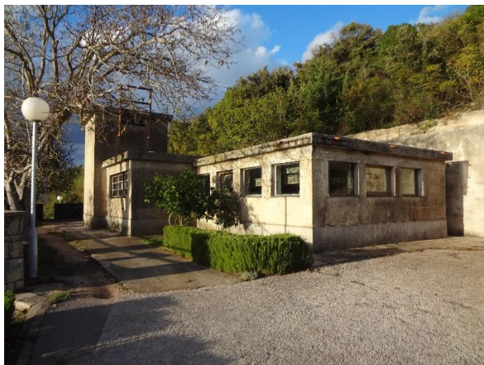
Slika 2.7. Stara crpna stanica na Vranskom jezeru na Cresu (izradio autor)
