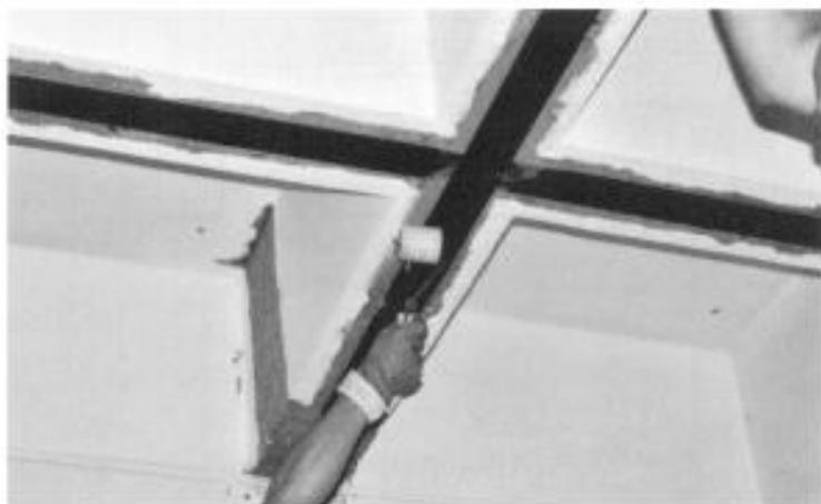
Slika 5: Pojačanje armiranobetonskih greda na savijanje s CFRP trakama [1]
