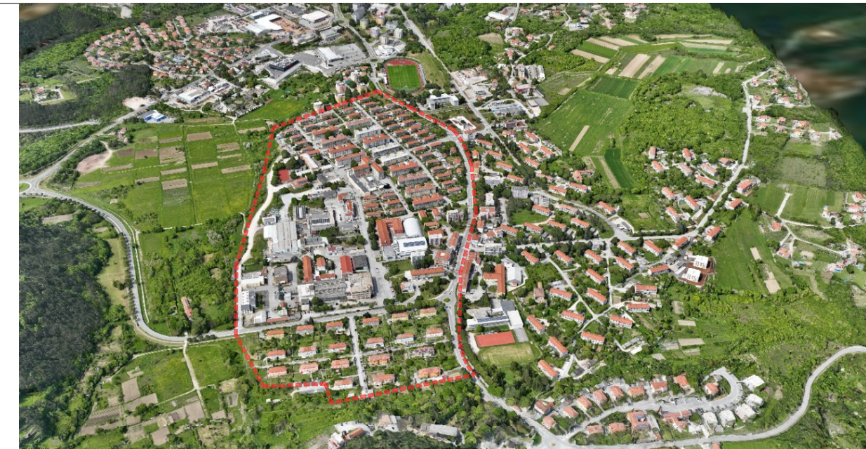
Pogled iz zraka 1 - Smjer sjeveroistok
