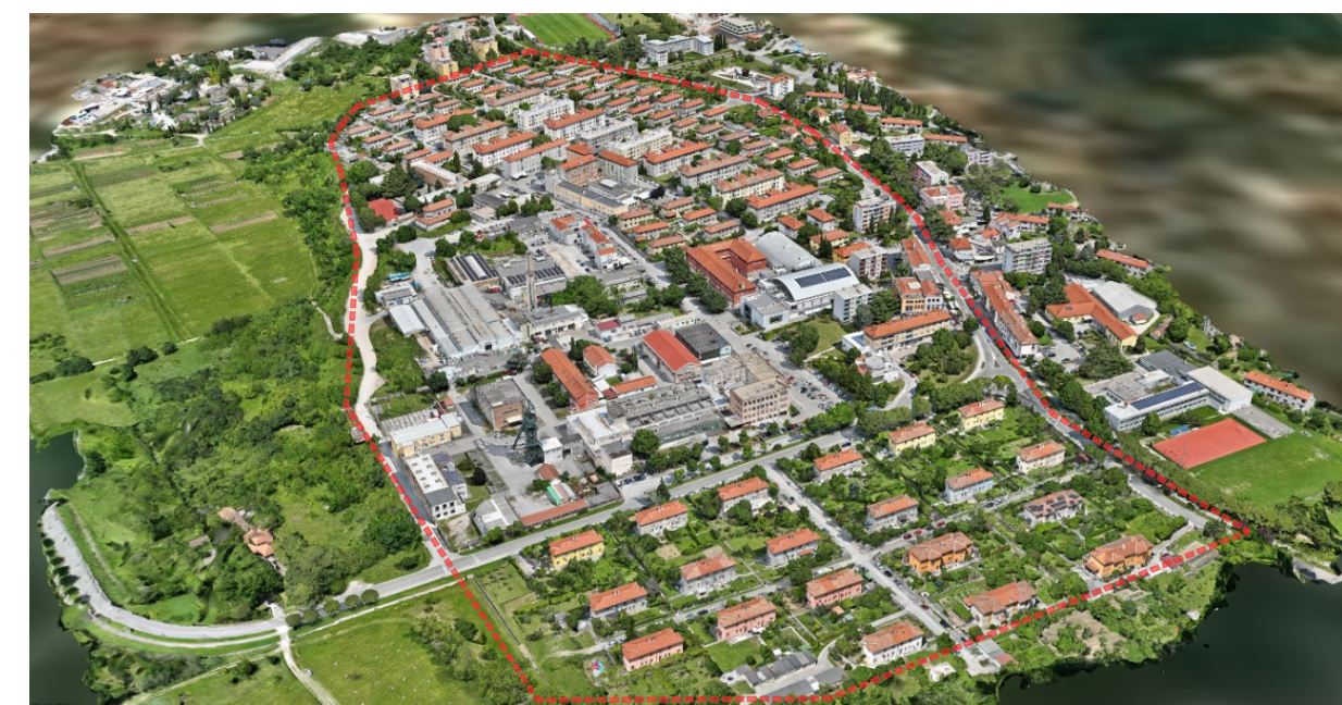
Pogled iz zraka 2 - Smjer sjeveroistok
