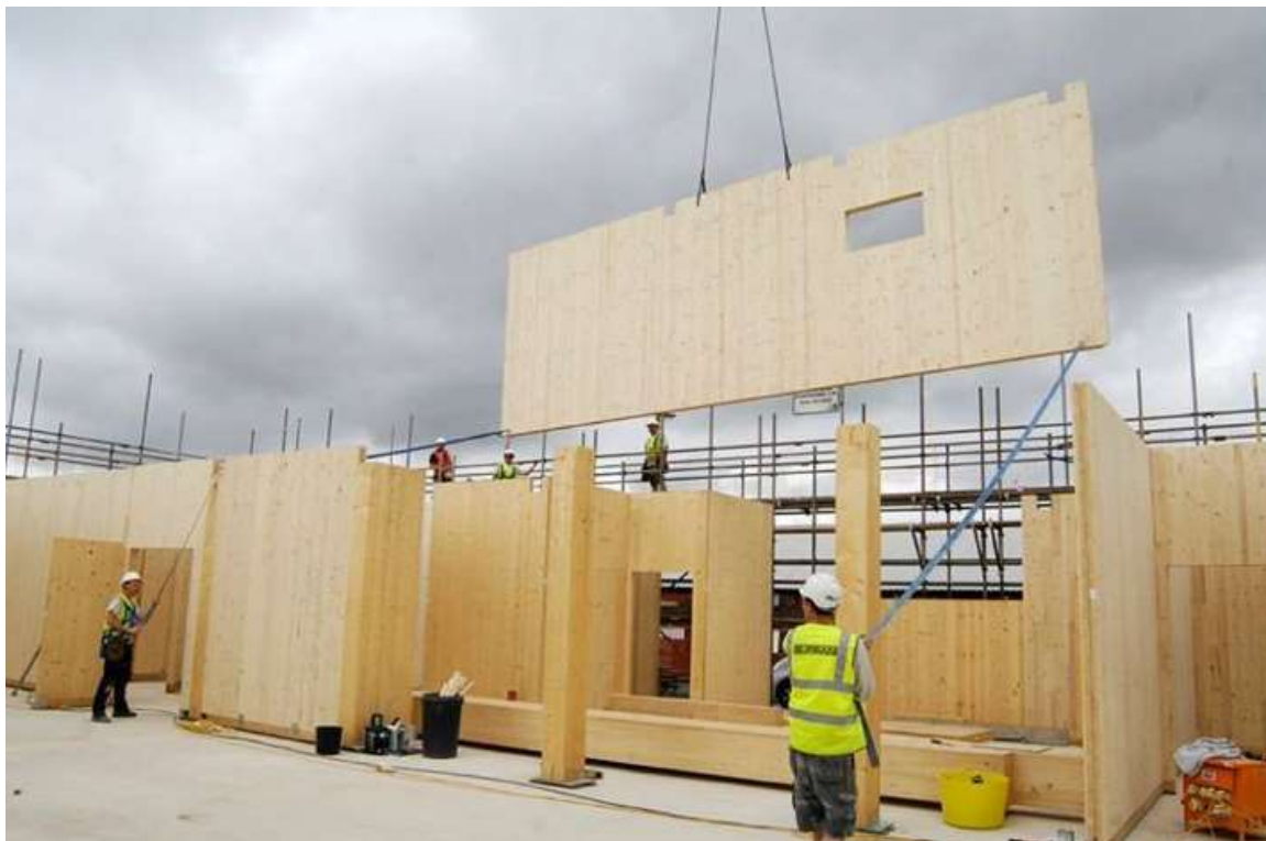
Slika 6: Montaža CLT elemenata (izvor: https://drvotehnika.info/clanci/razvoj-unakrsno-lepljenog-drveta-clt-panela , 26.05.2024.)
