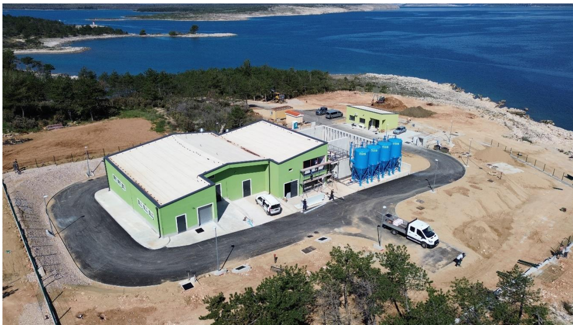
Slika 31. Prikaz UPOV-a prilikom završetka radova [15]
