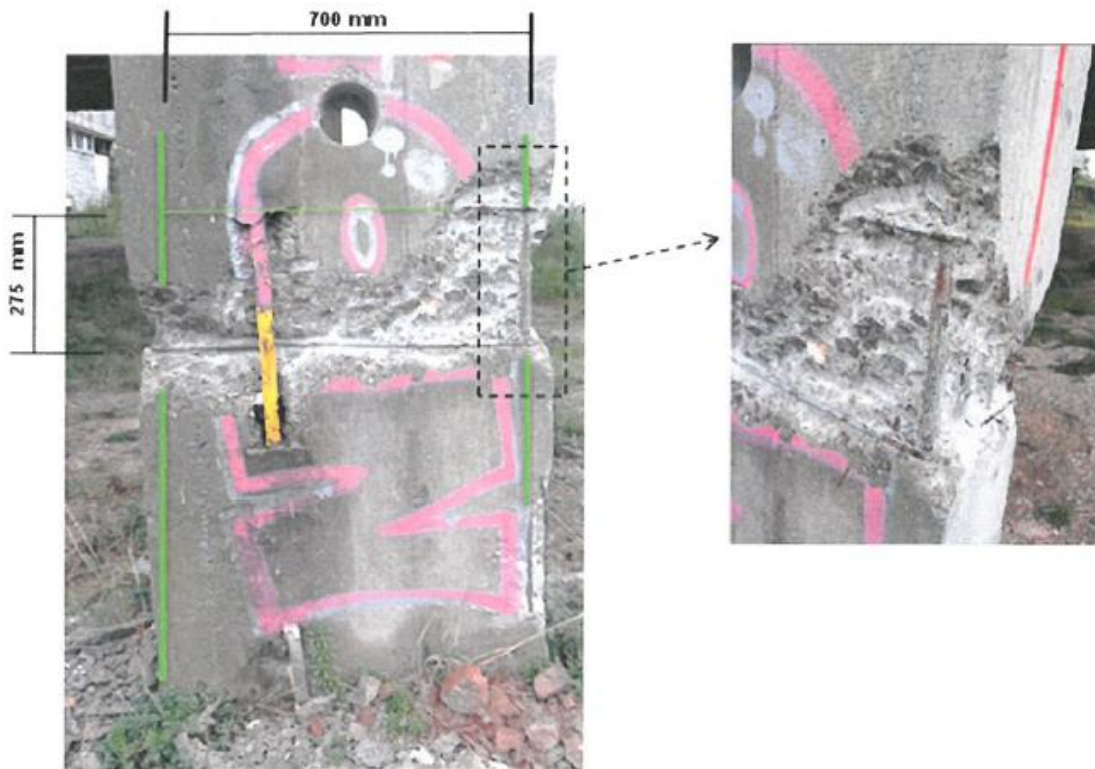
Slika 38 Terenska ispitivanja karakteristika armature [13]
