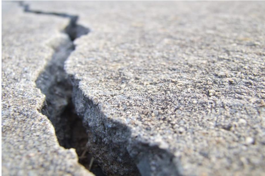
Slika 10 Konstrukcijske pukotine [14]
