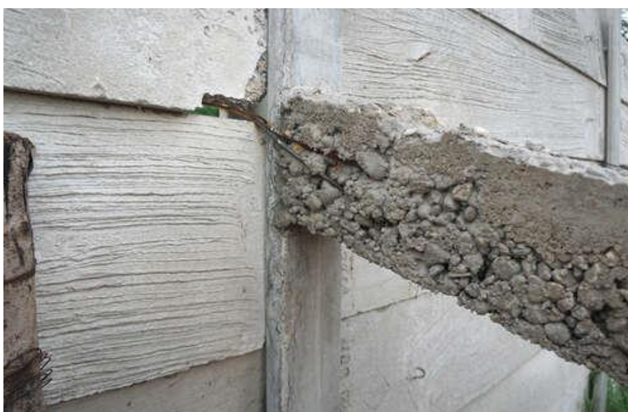
Slika 12 Segregacija betona [14]
