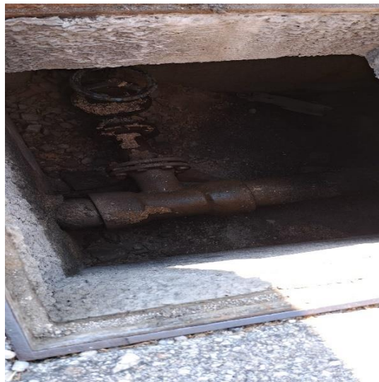
Slika 1. Postojeće stanje u oknu VO1.
