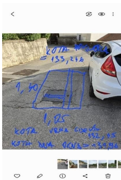
Slika 2. Shematski prikaz dimenzija okna s visinskim kotama.
