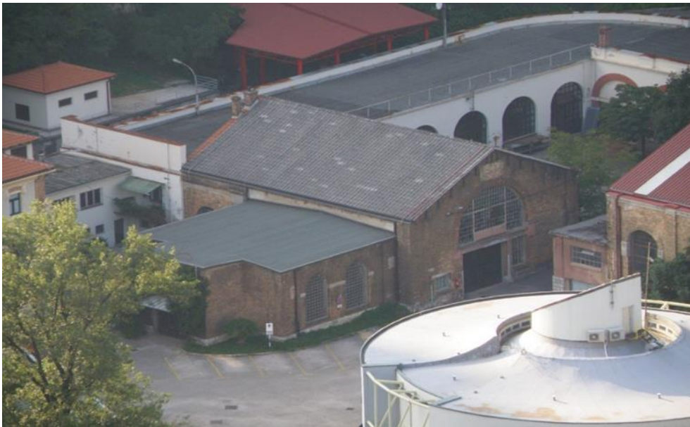
Slika 2. Zgrada Riječke spalionice smeća iz 1905.godine [8]
