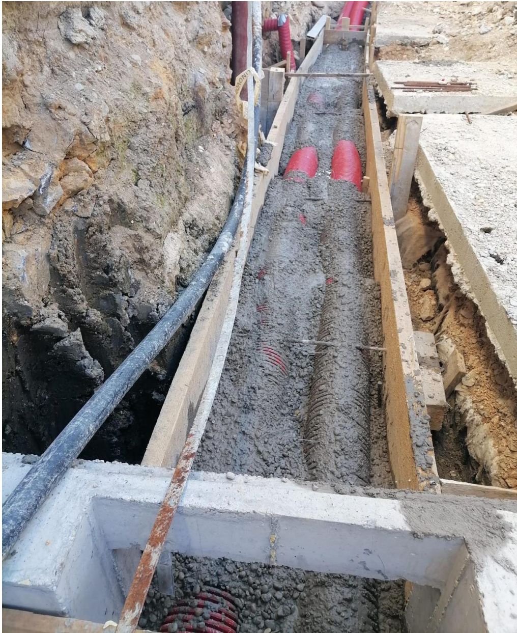
Slika 14: Primjer postavljanja rebraste cijevi za kabelsku kanalizaciju iz rekonstrukcije Zvijezde 4 (foto autor)
