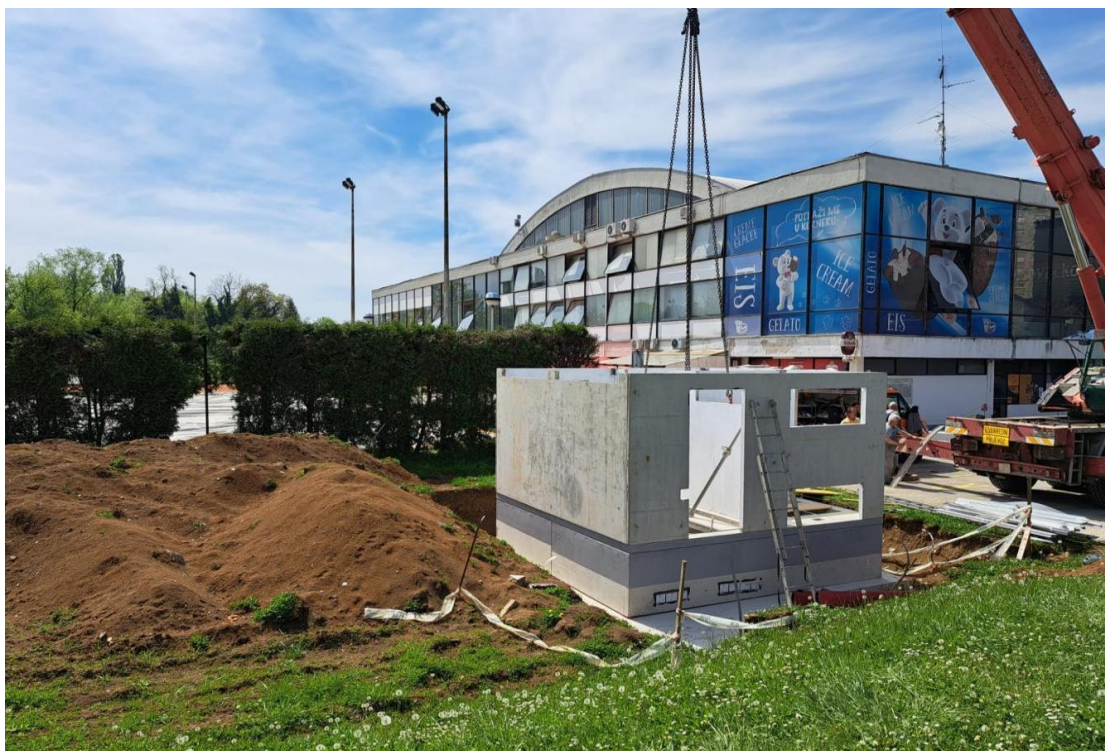
Slika 23: Montaža trafostanice “Foginovo” 1 (foto autor)
