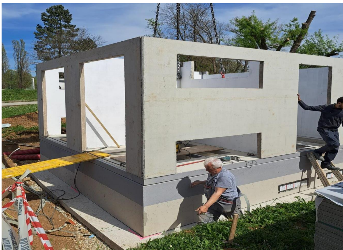
Slika 24: Montaža trafostanice “Foginovo” 2 (foto autor)
