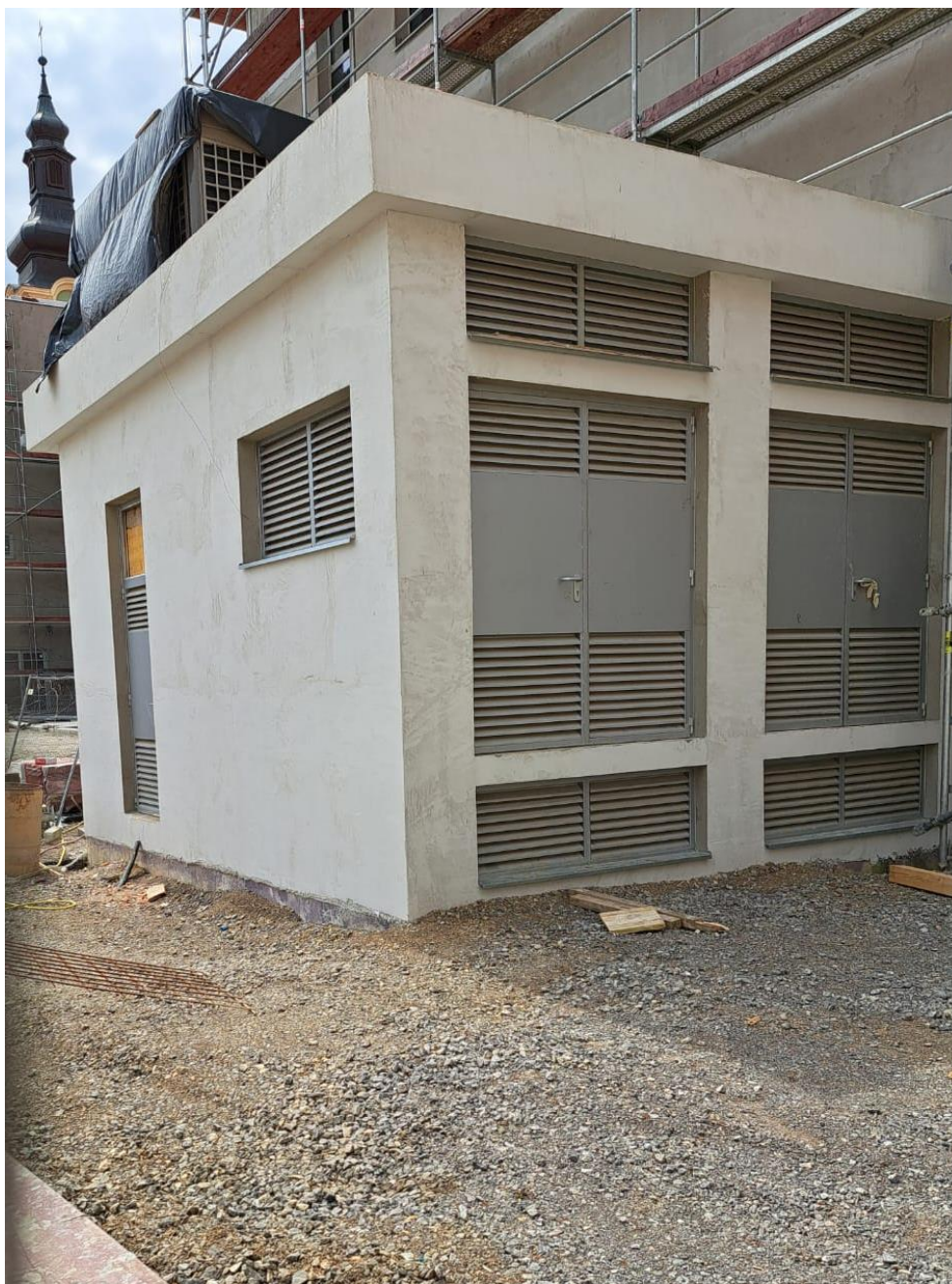
Slika 17: Trafostanica “Šimunićeva” (foto autor)
