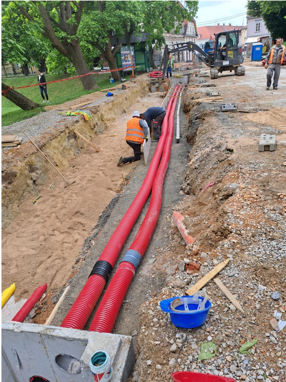
Slika 11: Primjer postavljanja rebraste cijevi za kabelsku kanalizaciju iz rekonstrukcije Zvijezde 1 (foto autor)
